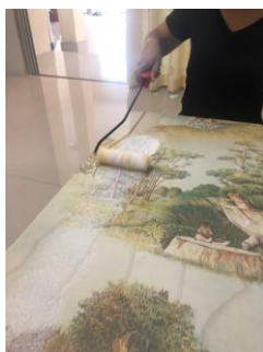
ภาพที่ 85 แสดงลักษณะการเกลี่ยน้ำยางชั้น โดยใช้ไม้ลูกกลิ้ง
