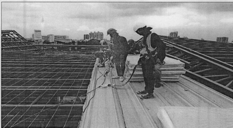
ภาพที่ 2-3 โครงสร้างหลังคาก่อนการติดตั้งหลังคา (บริษัทก่อสร้างรถไฟฟ้าในเขต กรุงเทพมหานครแห่งหนึ่ง, 2559)
