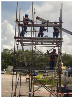
ภาพที่ 9 การติดตั้งคาน ตง
