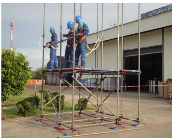
ภาพที่ 7 การติดตั้งราวกันตก โทบอร์ด และติดตั้งบันไดขั้นแรก ที่มา: ผู้วิจัยถ่ายเอง เมื่อวันที่ 25 มิถุนายน พ.ศ. 2558
