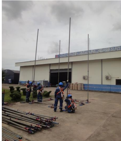
ภาพที่ 18 การจัดเก็บวัสดุอุปกรณ์นั่งร้าน ที่มา: ผู้วิจัยถ่ายเอง เมื่อวันที่ 25 มิถุนายน 2558
