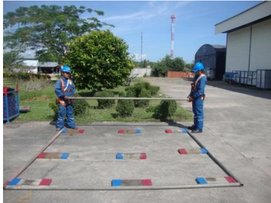
ภาพที่ 4 การวางกระดานรองพื้นนั่งร้าน
