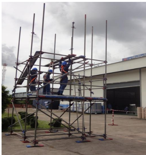
ภาพที่ 16 การรื้อถอนแผ่นกระดาน
