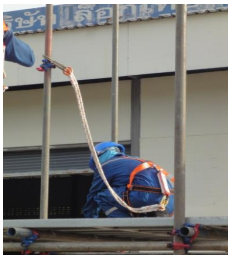
ภาพที่ 6 การปีนป่ายขึ้นเพื่อติดตั้งนั่งร้าน ที่มา: ผู้วิจัยถ่ายเอง เมื่อวันที่ 25 มิถุนายน พ.ศ. 2558
