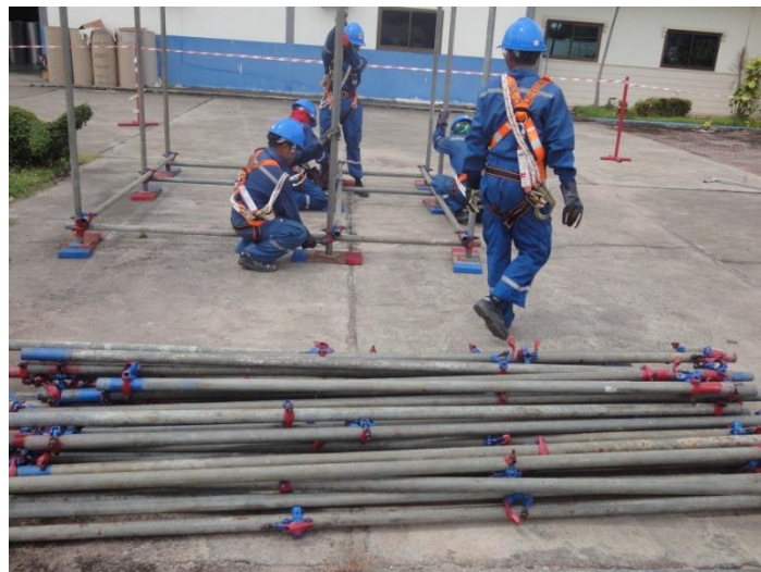
ภาพที่ 19 การรื้อถอนโดยให้แคล้มติดกับ คาน ตง ราวกันตก ที่มา: ผู้วิจัยถ่ายเอง เมื่อวันที่ 25 มิถุนายน พ.ศ. 2558
