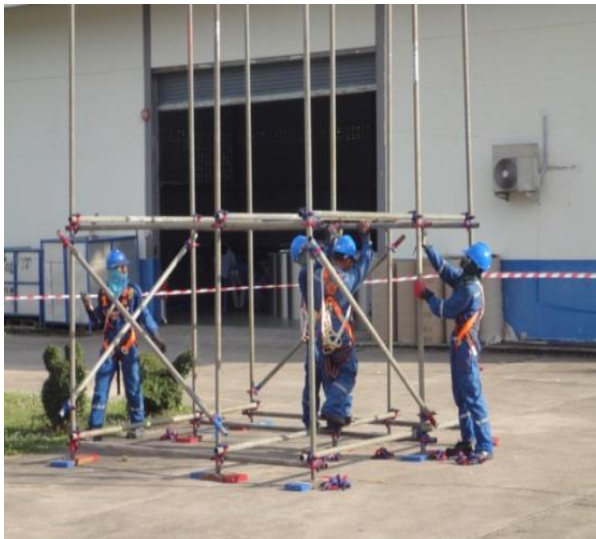
ภาพที่ 5 การติดตั้งชั้นแรกโดยเสานั่งร้าน ค้ำยัน และปูกระดาน
