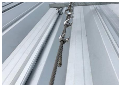
ภาพที่ 15 สลิงใส่เชือกสำหรับใช้เป็น Life line
