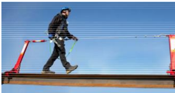
ภาพที่ 8 สายช่วยชีวิตแนวนราบ (Horizontal life line) (ที่มา http://www.safetylifethailand.com )
