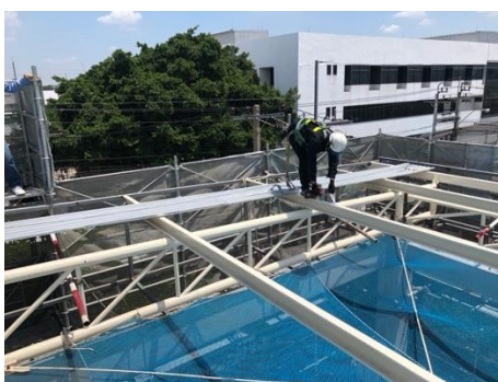
ภาพที่ 22 การนำระบบขั้วยั้งการตกส่วนบุคคลหลังการปรับปรุงไปใช้งาน
