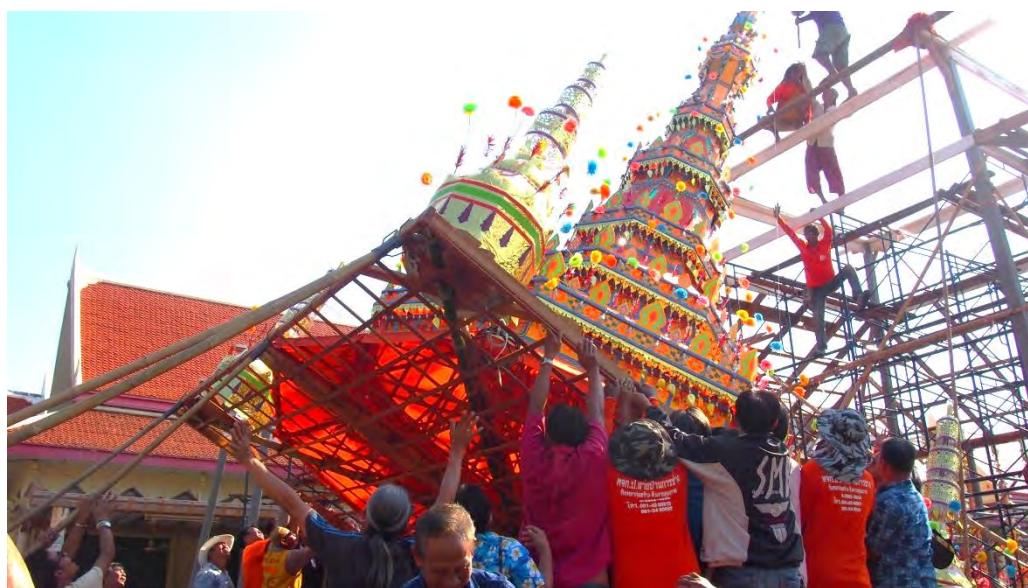
ภาพที่ 4-48 ชาวมอญร่วมกันยกยอดปราสาทมอญ การยกยอดปราสาทจะใช้วิธีชักลากโดยแรงคน เพื่อนำปราสาทยอดใหญ่สุดขึ้นตั้งบนยอดของเมรุ
