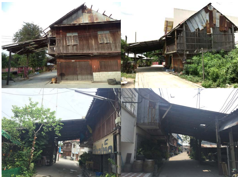
ภาพที่ 4-74 ลักษณะหลังคาคลุมบริเวณตลาดท่าตะกูคในบางบริเวณที่ยังคงเหลืออยู่
