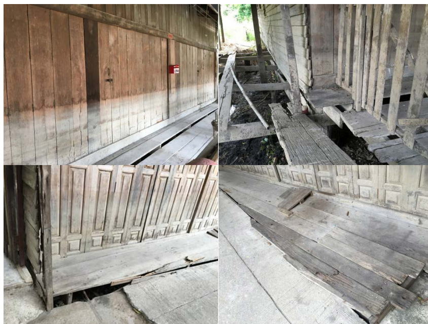
ภาพที่ 4-65 ลักษณะบ้านปลูกยกพื้นและพื้นไม้เก่าที่คาดว่าเป็นพื้นที่ตลาดเดิมเพราะสร้างริมฝั่งคลอง
