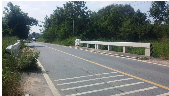
ภาพที่ 3-4 สะพานอนุสรณ์รัฐราษฎร์
