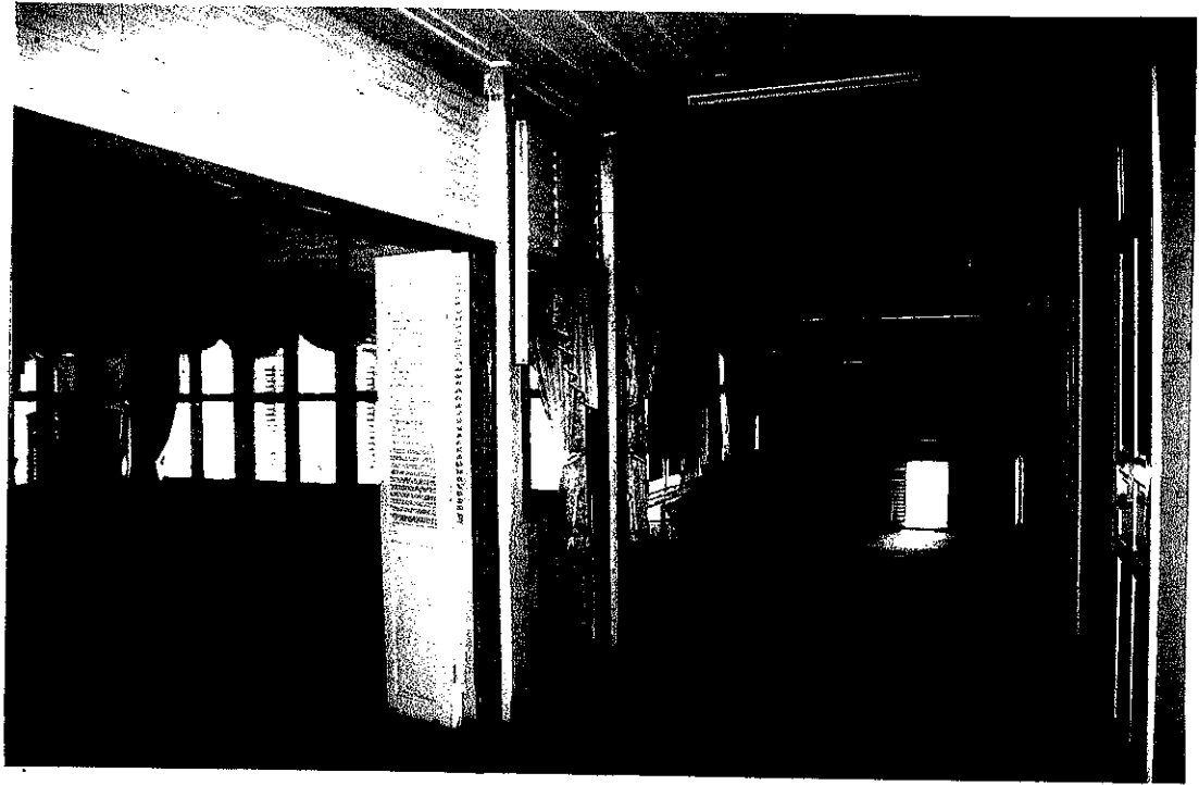
ภาพที่ 56 บริเวณมุขชั้นบนและระเบียงทางเดินด้านหน้าตำหนัก
