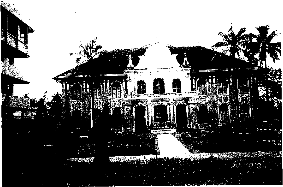
ภาพที่ 37 อาคารเจ้าพระยาอภัยภูเบศร ตั้งอยู่ริมแม่น้ำปราจีน (บางปะกง) หลังคาทำเป็นทรงปั้นหยา มุงด้วยกระเบื้องดินเผาชนิดไม่เคลือบ นำเข้าจากประเทศ ฝรั่งเศส พื้นผนังอาคารทาสีเหลืองออกน้ำตาล ตัวลวดลายทาสีขาว
