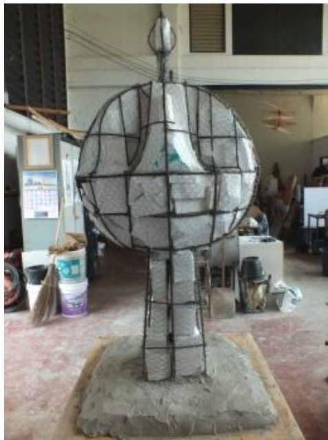
ภาพที่ ๓-๓๔ ขั้นตอนที่ ๔ การอัดโฟมภายในโครงเหล็ก(ด้านหลัง)
