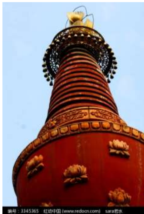
ภาพที่ 2-21 การแกะสลักนูนสูงบนหอคอยในทิเบต ( http://sucan.redocn.com )
