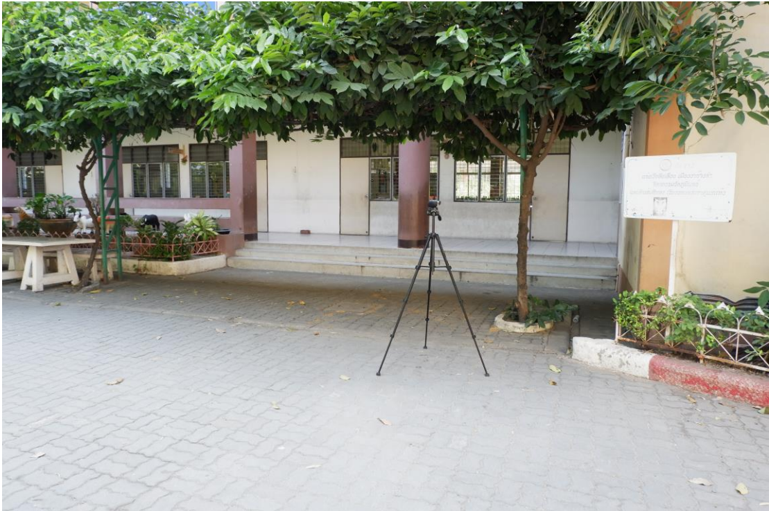
ภาพภาคผนวก ก-8 จุดตรวจวัดที่ 7 อาคารเรียน 5
