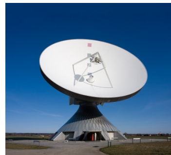
(จ) สายอากาศจาน
