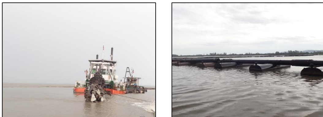
ภาพที่ 4-27 การขุดลอกร่องน้ำบริเวณสถานี T7 และ T12 บริเวณอ่าวตราด จังหวัดตราด เดือนกันยายน พ.ศ. 2560
