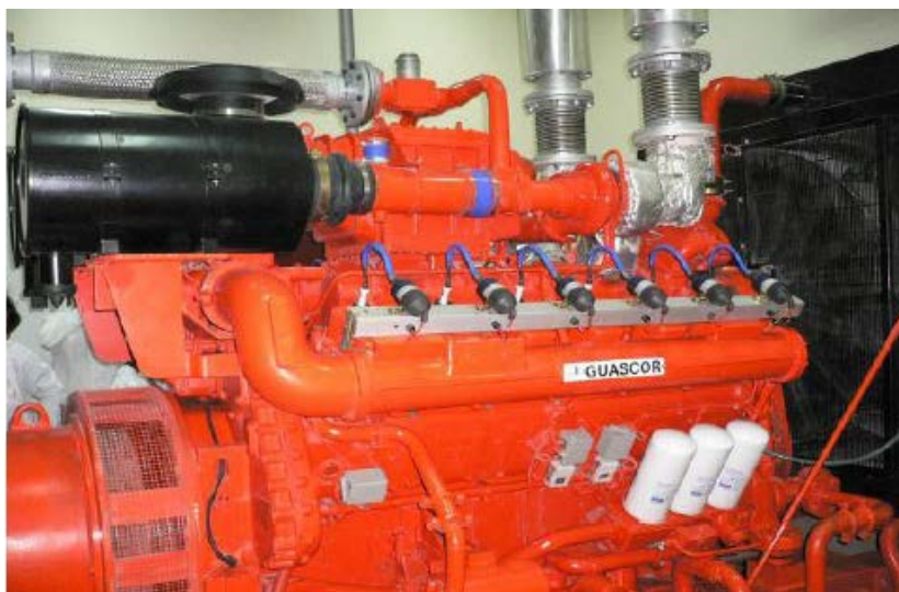
ภาพที่ 3-13 เครื่องยนต์สันดาปใน 4 จังหวะ
