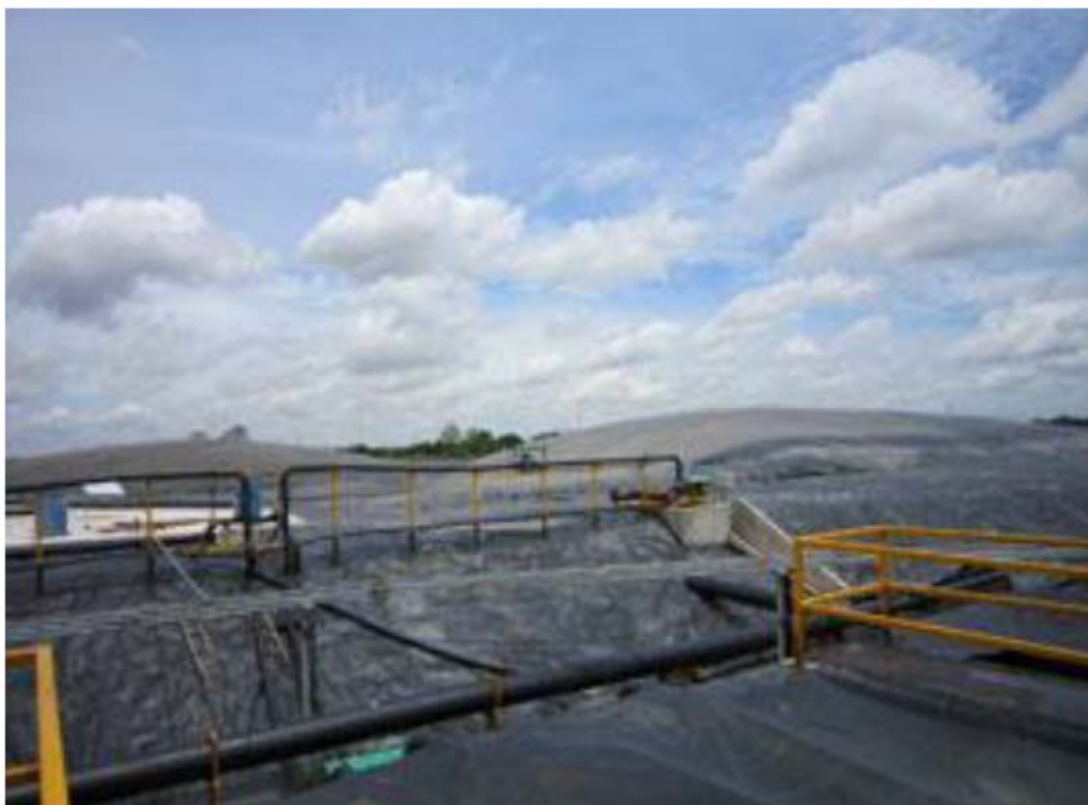
ภาพที่ 2-5 ลักษณะของบ่อปิดแบบไม่ใช้อากาศดัดแปลง (Modified anaerobic covered lagoon)
