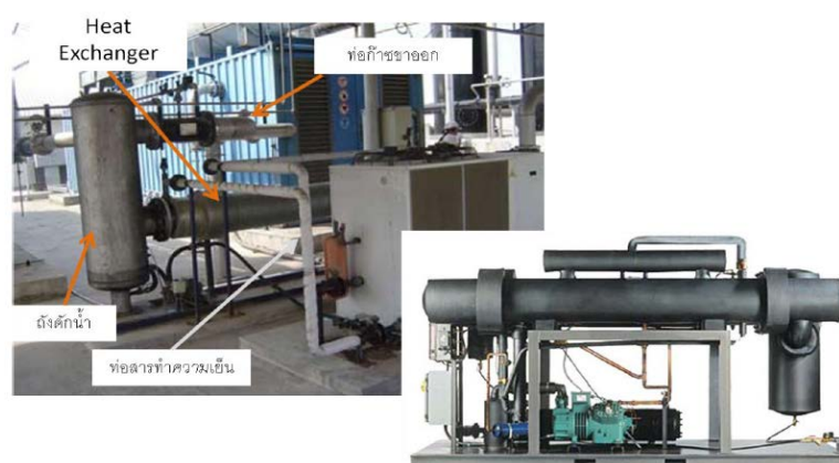
ภาพที่ 3-4 การกำจัดความชื้นและละอองน้ำออกจากก๊าซชีวภาพโดยสารทำความเย็น (คู่มือการปฏิบัติงาน เกี่ยวกับการออกแบบ การผลิต การควบคุมคุณภาพ และ การใช้ก๊าซชีวภาพ (Biogas) สำหรับโรงงานอุตสาหกรรม, 2553)
