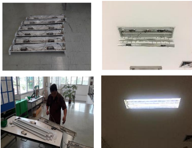
ภาพที่ 4-16 การเปลี่ยนหลอดไฟฟ้าฟลูออเรสเซนต์ในอาคารสำนักงาน
