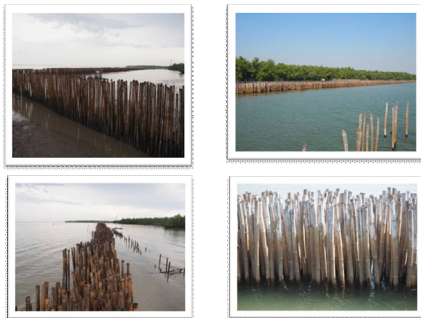
ภาพที่ 9 มาตรการการป้องกันและแก้ไขการกัดเซาะชายฝั่งโดยใช้ไม้ไผ่ชะลอกคลื่น ของชายฝั่ง จังหวัดสมุทรสงครามและจังหวัดสมุทรสาคร (ภาพถ่ายเมื่อวันที่ 17 มกราคม พ.ศ. 2559)
