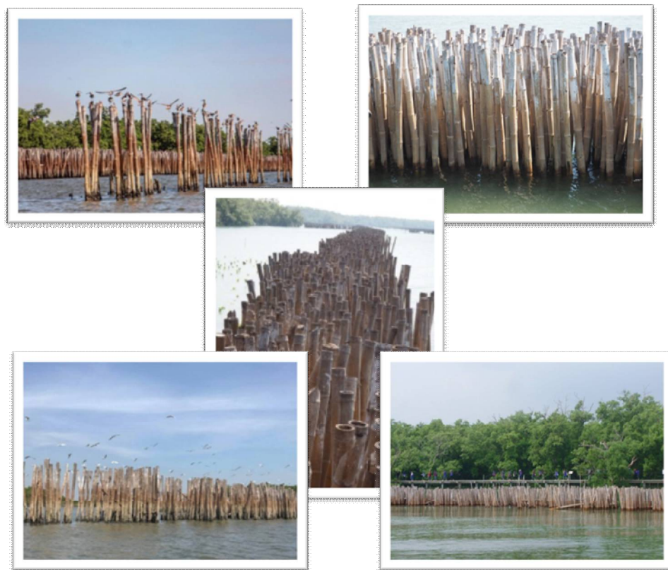
ภาพที่ 41 สภาพไม้ไผ่ชะลอกลิ่นในปัจจุบันที่เกิดจากการแกล่นำร่วมกับชาวบ้านในชุมชน ร่วมกันดำเนินงาน โดยได้รับงบประมาณสนับสนุนจากภายนอกผ่านการประสานงาน โดยแกล่นำ ทำให้มีงบประมาณมาซ่อมแซมดูแลอย่างต่อเนื่อง
