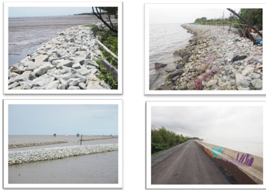
ภาพที่ 8 มาตรการการป้องกันและแก้ไขการกัดเซาะชายฝั่งโดยใช้เขื่อนหินทิ้ง ของชายฝั่ง จังหวัดสมุทรปราการและจังหวัดฉะเชิงเทรา (ภาพถ่ายเมื่อวันที่ 1 พฤศจิกายน พ.ศ.2558)
