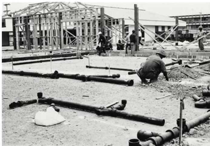
แผนที่ 37 คนงานไทยกำลังก่อสร้าง Plumbing Project ที่อุตะเถาประเทศไทย Photo by Jim Larkin (Red Horse Country, 2016)
