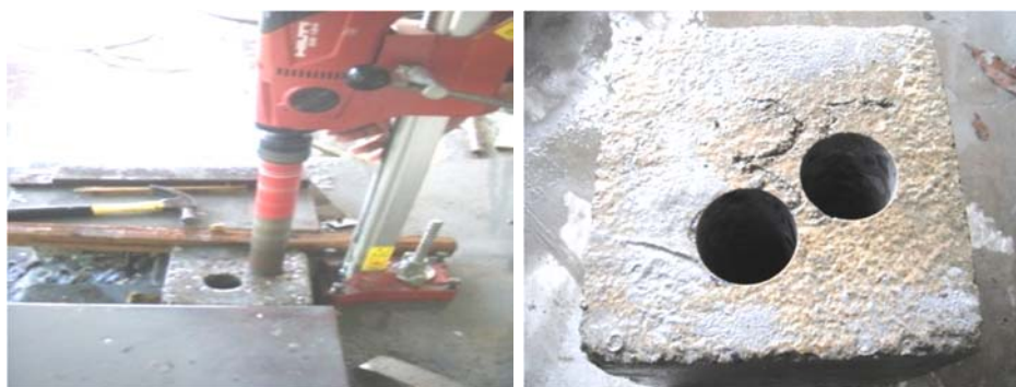
ภาพที่ 3-20 เครื่องเจาะคอนกรีตขณะทำงาน และตำแหน่งเจาะเพื่อนำแท่งคอนกรีตมาทดสอบ
