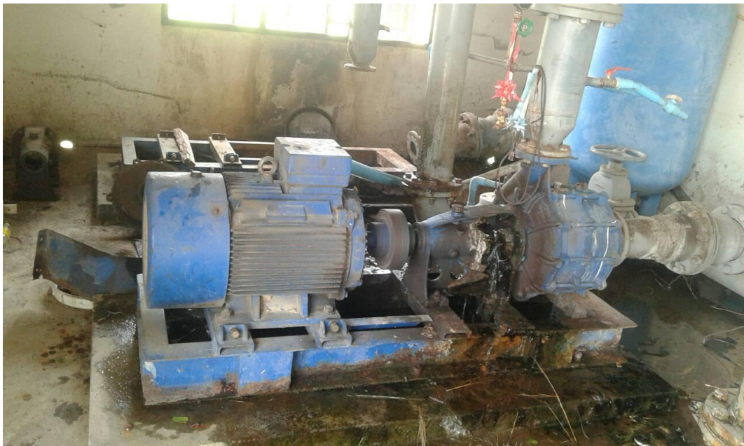
ภาพที่ 4-7 ป้อนน้ำมีปัญหาเสียบ่อย หมู่ที่ 1
