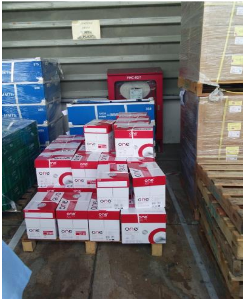
ภาพที่ 4-1 การวางสินค้าหรือชิ้นส่วนหน้าตู้ดับเพลิง
