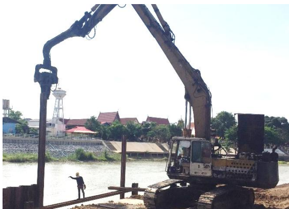
ภาพที่ 2-5 การตอกเสาเข็มพีคระบบสันสะเทือน
