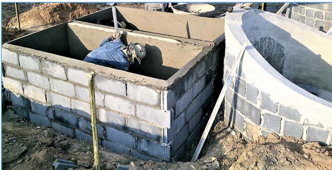
ภาพที่ 5-11 ฮวงซุ้ยที่กำลังก่อสร้าง
