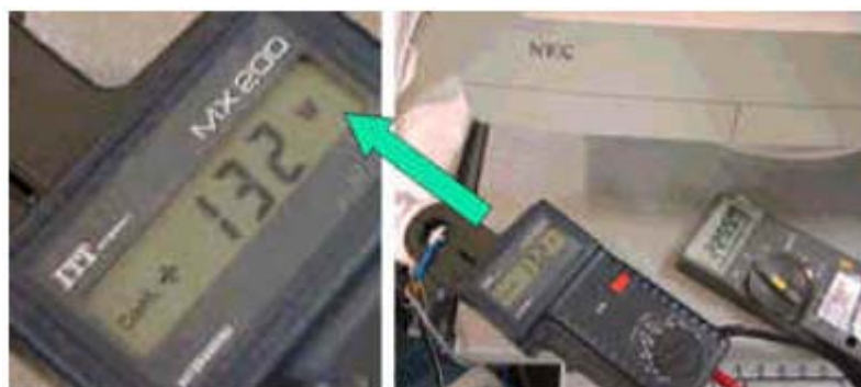
ภาพที่ 2-11 การใช้ Power Meter วัดค่ากำลังไฟฟ้าของจอคอมพิวเตอร์ 17" (ที่มา Leonics Co., Ltd.)
