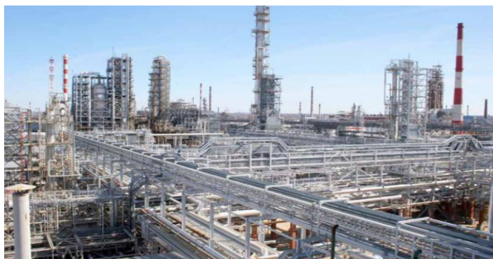
ภาพที่ 1-1 ระบบท่อ โรงกลั่นน้ำมัน และ โรงแยกก๊าซ (Central control administration of the fuel and energy complex, 2016)
