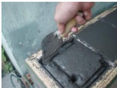
(จ) ใช้เกรียงเกลี่ยคอนกรีตสคให้เต็มแบบหล่อ
