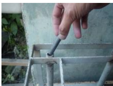
(ค) หย่อนเหล็กลงในคอนกรีต
