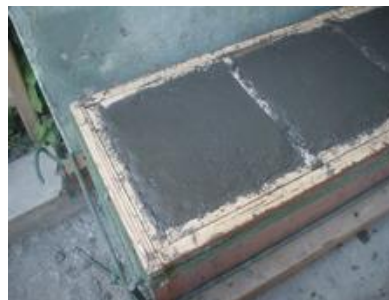
(จ) ใช้เกรียงเกลี่ยคอนกรีตสคให้เต็มแบบหล่อ
