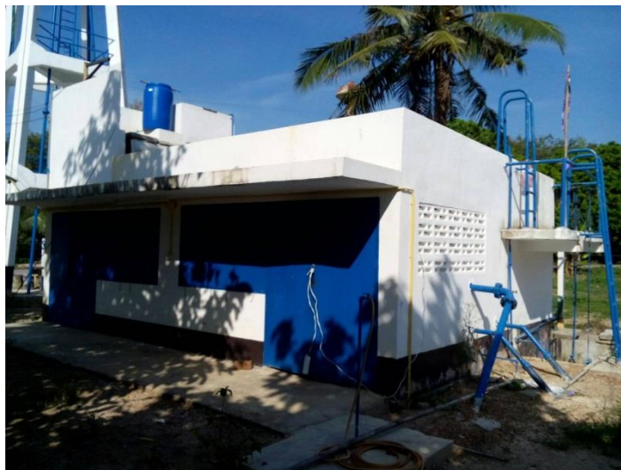
ภาพภาคผนวกที่ ข-80 ถังกรองน้ำ ขนาด 10 ลูกบาศก์เมตร
