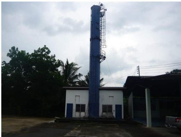
ภาพภาคผนวกที่ ข-24 ถึงสูงเหล็ก ขนาด 24 ลูกบาศก์เมตร
