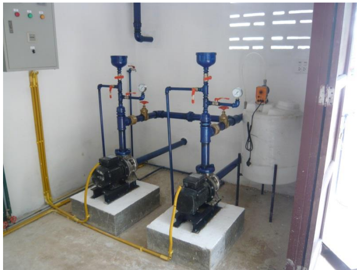
ภาพภาคผนวกที่ ข-35 เครื่องสูบน้ำดี ขนาด 2 แรงม้า 1 เฟส และชุดจ่ายสารละลายคลอรีน
