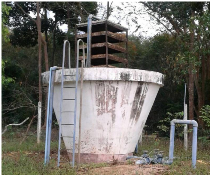
ภาพภาคผนวกที่ ข-54 ถังกรองทราย ขนาด 10 ลูกบาศก์เมตร/ ชั่วโมง
