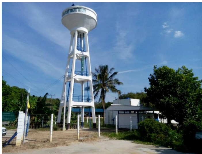
ภาพภาคผนวกที่ ข-84 หอถังสูง ขนาด 30 ลูกบาศก์เมตร
