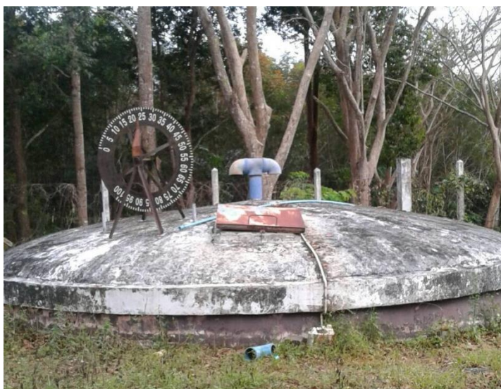
ภาพภาคผนวกที่ ข-55 ถังน้ำใส ขนาด 100 ลูกบาศก์เมตร
