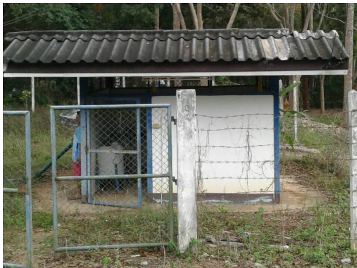
ภาพภาคผนวกที่ ข-53 โรงสูบน้ำดิบ-น้ำดี
