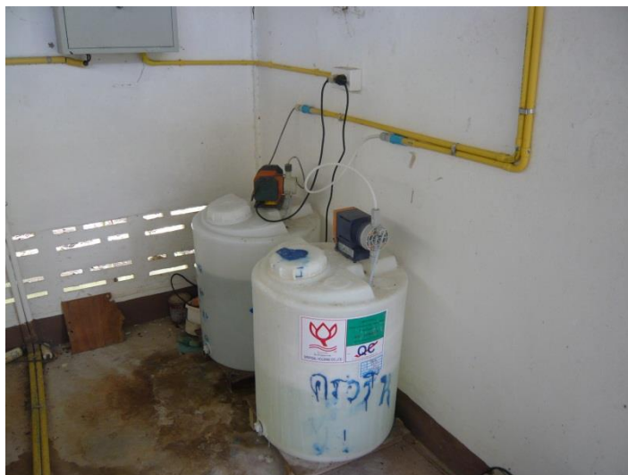
ภาพภาคผนวกที่ ข-92 ชุดจ่ายสารละลายสารส้มและคลอรีน
