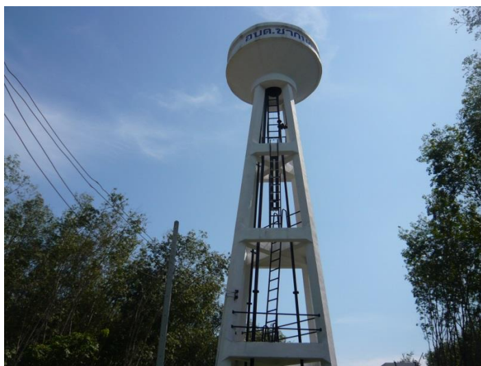
ภาพภาคผนวกที่ ข-36 หอดังสูง ขนาด 15 ลูกบาศก์เมตร
