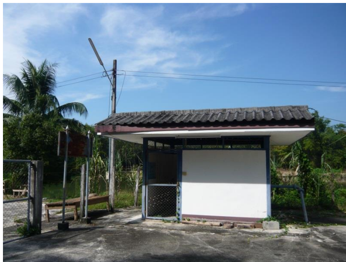
ภาพภาคผนวกที่ ข-66 โรงสูบน้ำดิบ
