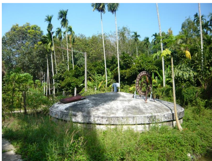
ภาพภาคผนวกที่ ข-69 ถังน้ำใส ขนาด 100 ลูกบาศก์เมตร
