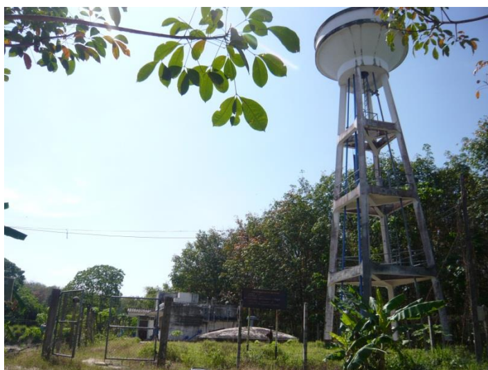
ภาพภาคผนวกที่ ข-98 ประตูและรั้วรอบระบบประปา
