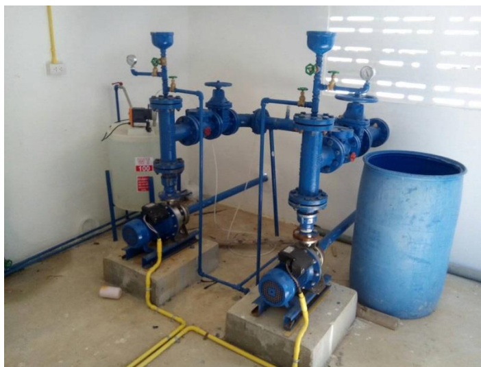
ภาพภาคผนวกที่ ข-82 เครื่องสูบน้ำดี ขนาด 3 แรงม้า 1 เฟส
