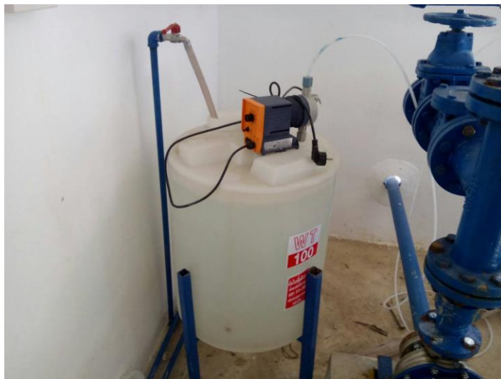
ภาพภาคผนวกที่ ข-83 ชุดจ่ายสารละลายคลอรีน
