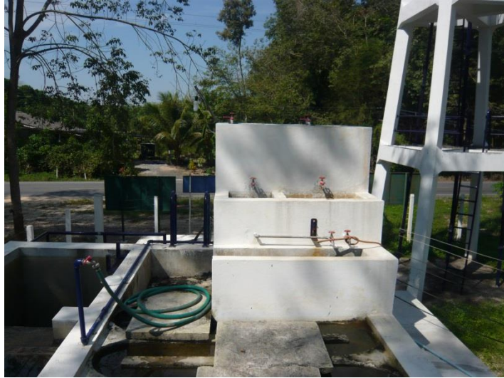
ภาพภาคผนวกที่ ข-32 ถังจ่ายสารละลายสารส้มและปูนขาว
