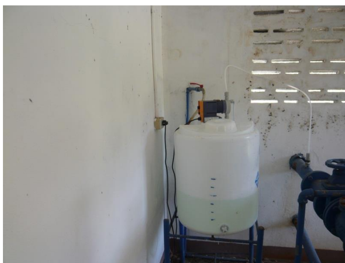
ภาพภาคผนวกที่ ข-96 ชุดจ่ายสารละลายคลอรีน
