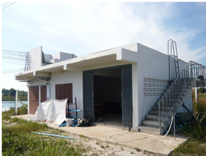
ภาพภาคผนวกที่ ข-104 ถังกรองน้ำฝิวดิน ขนาด 20 ลูกบาศก์เมตร/ ชั่วโมง
