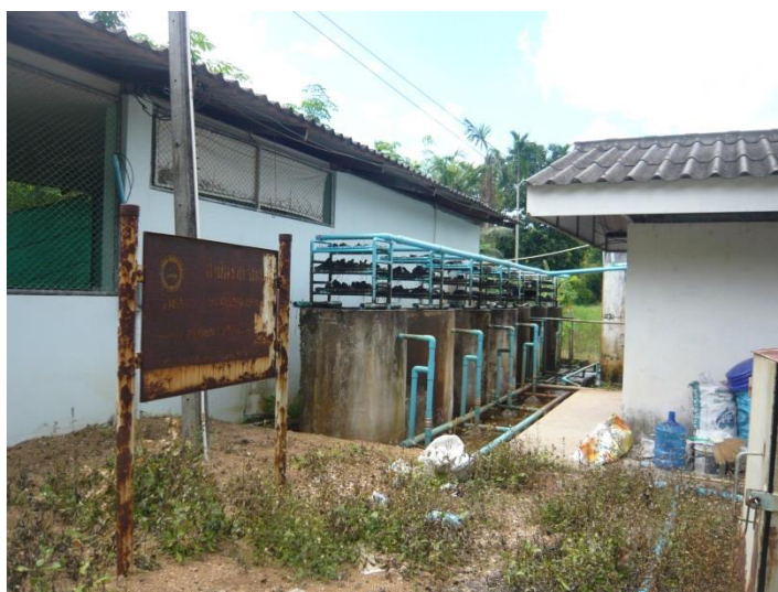
ภาพภาคผนวกที่ ข-45 ชุดถังกรองน้ำฝิวดิน ขนาด 10 ลูกบาศก์เมตร/ ชั่วโมง
