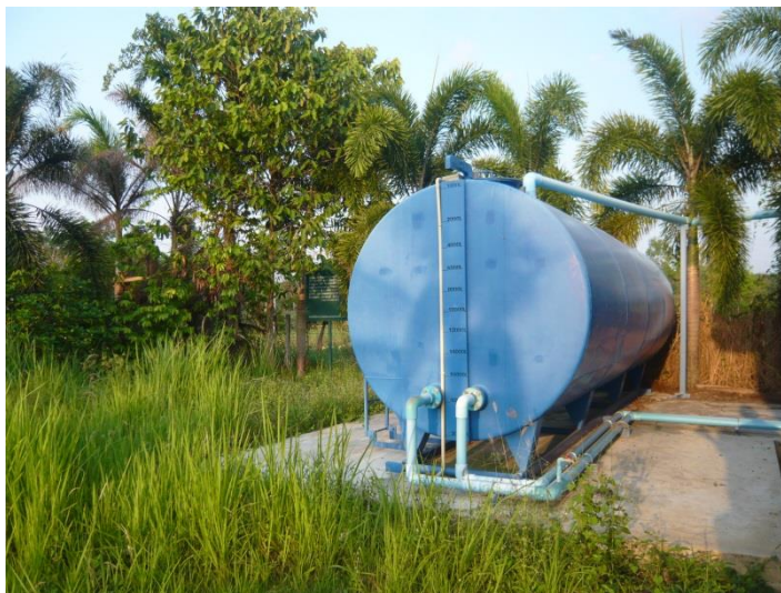
ภาพภาคผนวกที่ ข-8 ถังน้ำใสเหล็ก ขนาด 20 ลูกบาศก์เมตร
