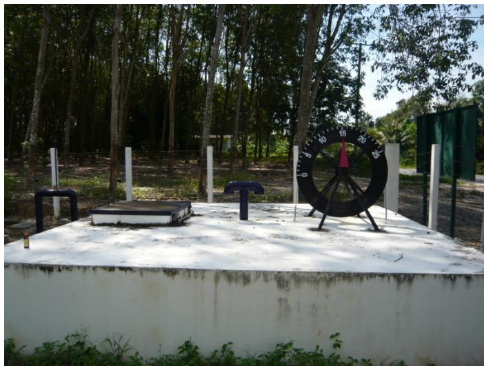
ภาพภาคผนวกที่ ข-34 ถังน้ำใส ขนาด 25 ลูกบาศก์เมตร
