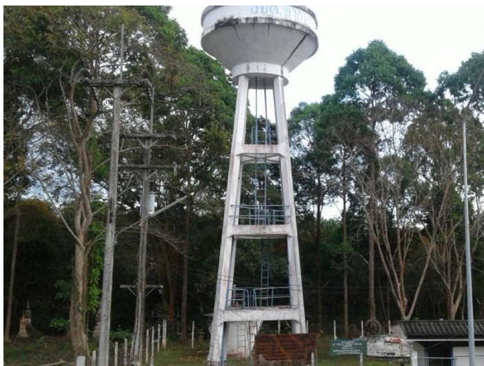
ภาพภาคผนวกที่ ข-57 หอถังสูง ขนาด 30 ลูกบาศก์เมตร
