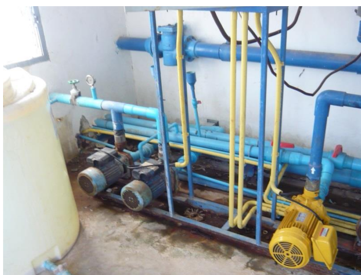
ภาพภาคผนวกที่ ข-9 เครื่องสูบน้ำดิบ-น้ำดี ขนาด 3 แรงม้า 3 เฟส จำนวน 1 ชุด
