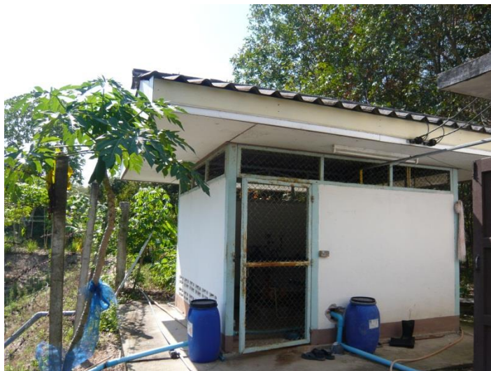
ภาพภาคผนวกที่ ข-90 โรงสูบน้ำดิบ
