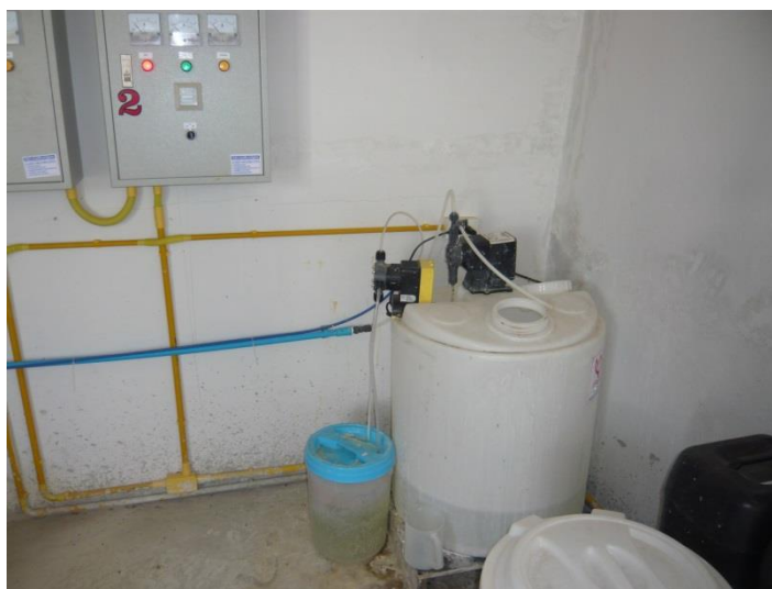
ภาพภาคผนวกที่ ข-103 ชุดจ่ายสารละลายสารส้มและคลอรีน
