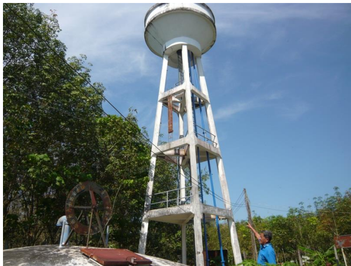
ภาพภาคผนวกที่ ข-97 หอดังสูง ขนาด 30 ลูกบาศก์เมตร
