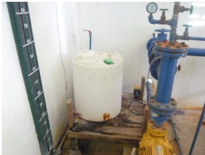
ภาพภาคผนวกที่ ข-71 ชุดจ่ายสารละลายคลอรีน
