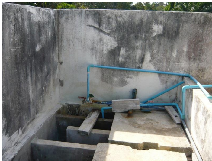
ภาพภาคผนวกที่ ข-67 ถังจ่ายสารละลายสารส้มและปูนขาว
