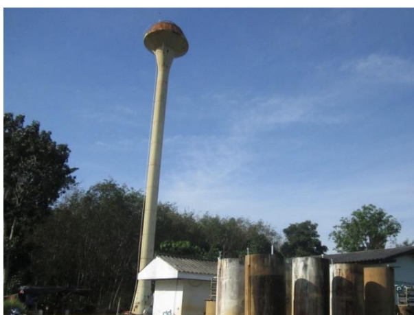
ภาพภาคผนวกที่ ข-47 หอถังสูง ขนาด 20 ลูกบาศก์เมตร
