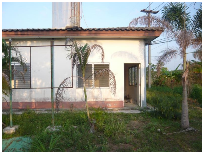
ภาพภาคผนวกที่ ข-3 อาคารควบคุมการผลิตน้ำประปาหมู่บ้าน บ้านชากกอไผ่
