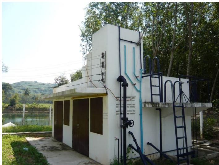
ภาพภาคผนวกที่ ข-33 ถังกรองน้ำฟิวคิน ขนาด 7 ลูกบาศก์เมตร/ ชั่วโมง
