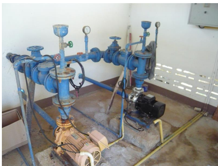
ภาพภาคผนวกที่ ข-91 เครื่องสูบน้ำดิบ ขนาด 3 แรงม้า 1 เฟส
