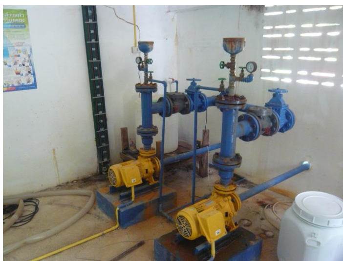
ภาพภาคผนวกที่ ข-70 เครื่องสูบน้ำดี ขนาด 3 แรงม้า 1 เฟส
