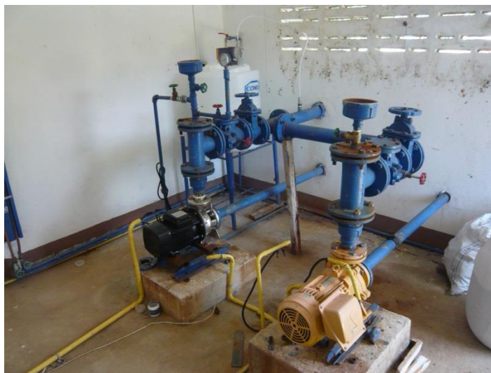
ภาพภาคผนวกที่ ข-95 เครื่องสูบน้ำดี ขนาด 3 แรงม้า 1 เฟส
