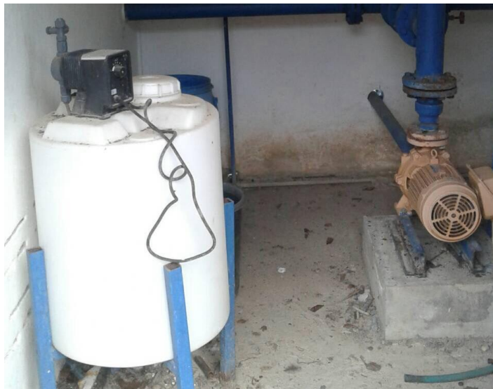
ภาพภาคผนวกที่ ข-56 ชุดจ่ายสารละลายคลอรีนและเครื่องสูบน้ำดี
