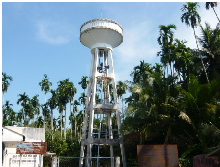
ภาพภาคผนวกที่ ข-72 หอถังสูง ขนาด 30 ลูกบาศก์เมตร
