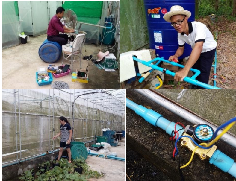
ภาพที่ 8 การติดตั้งระบบน้ำสำหรับการปลูกเมล่อนในโรงเรือน
