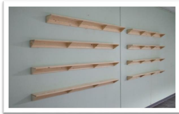
ภาพที่ ๗๙ การติดตั้งชั้นวางผลงานบนผนัง
