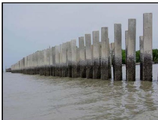
ภาพที่ 2-15 แนวปักเสาเข็มคอนกรีตหล่อแบบสี่เหลี่ยมของวัดขุนสมุทรราชต่อด้วยคอนกรีตหล่อแบบสามเหลี่ยม 49A2 ของจุฬาลงกรณ์มหาวิทยาลัย บริเวณวัดขุนสมุทรราช ตำบลแหลมฟ้า อำเภอพระสมุทรเจดีย์ จังหวัดสมุทรปราการ
