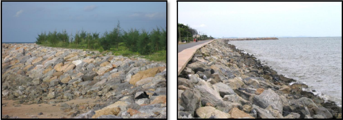
ภาพที่ 2-9 กำแพงป้องกันคลื่นริมชายหาดโดย การปูหรือเรียงก้อนหินบนหน้าหาดโดยตรง บริเวณพระราชินีเวสต์มฤตทายวัน อำเภอชะอำ จังหวัดเพชรบุรี (ซ้าย) และการปูหรือเรียงก้อนหินซ้อนทับไว้หน้ากำแพงป้องกันคลื่นริมชายฝั่งบริเวณหาดทรายทอง อำเภอมาบตาพุด จังหวัดระยอง (ขวา)
