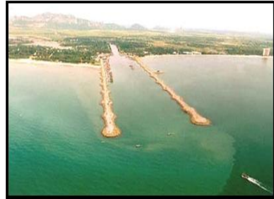
ภาพที่ 2-14 เชือกั้นทรายและคลื่น (บน) บริเวณปากคลองชะอำของบริษัท ชลประทานซีเมนต์ อำเภอลำลูกกา จังหวัดเพชรบุรี (ซ้าย) และ บริเวณปากแม่น้ำปราณบุรี ตำบลปากน้ำปราณ อำเภอปราณบุรี จังหวัดประจวบคีรีขันธ์ (ขวา)
