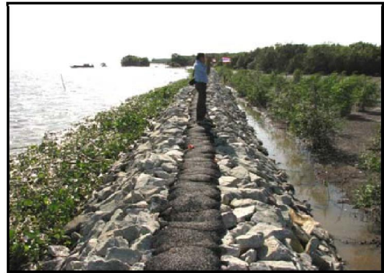
ภาพที่ 2-11 กำแพงป้องกันคลื่นใกล้ชายฝั่งแบบหินทิ้งหรือหินเรียงฐานรากเข็มสน บริเวณ บ้านสีลังตำบลสองคลอง อำเภอบางปะกง จังหวัดฉะเชิงเทรา
