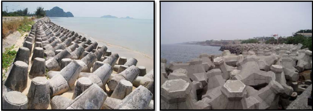
ภาพที่ 2-10 ก้อนคอนกรีตหล่อรูปสี่ขา (Tetra pod) ปูเรียงไว้หน้าชายหาดบริเวณปากน้ำบางนรา จังหวัดนราธิวาส (ซ้าย)
