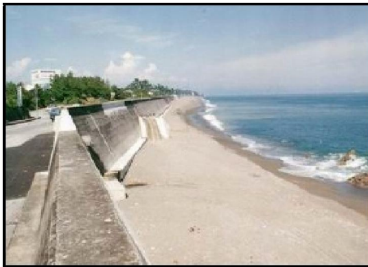
ภาพที่ 2-7 กำแพงป้องกันคลื่นริมชายหาดแบบลาดเอียง ก่อนฐานรากถูกกัดเซาะ (ซ้าย) และ หลังฐานรากถูกกัดเซาะ (ขวา)
