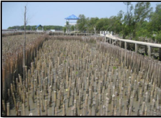
ภาพที่ 2-4 การปักไม้ไผ่ตงชะลอคั่นและปลูกป่าชายเลนบริเวณศูนย์อนุรักษ์ทรัพยากรทางทะเลและชายฝั่งที่ 2 (สมุทรสาคร) ตำบลโคกขาม อำเภอเมือง จังหวัดสมุทรสาคร ที่มา : กรมทรัพยากรทางทะเลและชายฝั่ง, 2553
