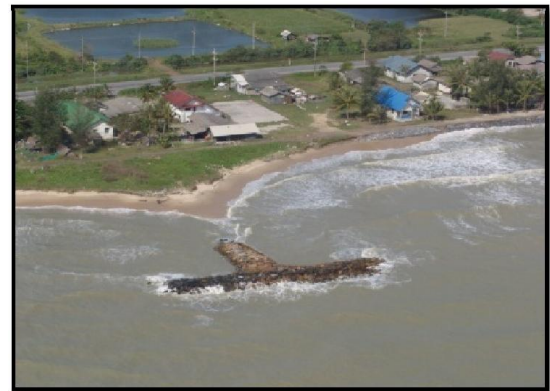
ภาพที่ 2-13 (ซ้าย) รอดักทรายแบบแนวตรงร่วมกับการถมทรายเสริมชายหาดบริเวณอำเภอตากใบจังหวัดนราธิวาส
