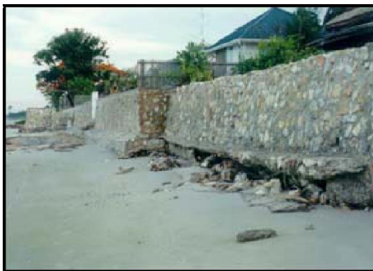
ภาพที่ 2-6 กำแพงป้องกันคลื่นริมชายหาดแบบตั้งตรง อำเภอหัวหิน จังหวัดประจวบคีรีขันธ์ (ซ้าย) และบริเวณอ่าวน้อย ตำบลอ่าวน้อย อำเภอเมือง จังหวัดประจวบคีรีขันธ์ (ขวา)
