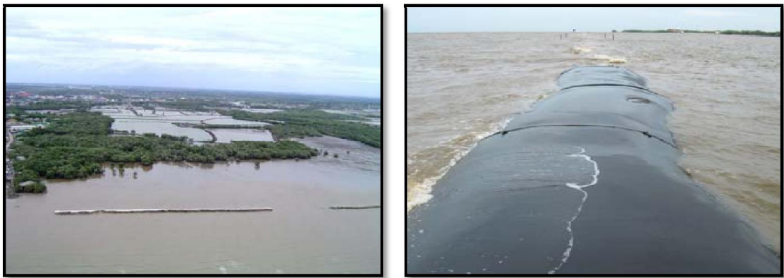
ภาพที่ 2-5 การใช้ไส้กรอกทรายเป็นแนวป้องกันและแก้ไขปัญหาการกัดเซาะบริเวณชายฝั่งทะเล อำเภอลองด่าน จังหวัดสมุทรปราการ ที่มา : กรมทรัพยากรทางทะเลและชายฝั่ง , 2553
