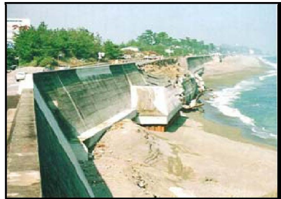
ภาพที่ 2-7 กำแพงป้องกันคลื่นริมชายหาดแบบลาดเอียง ก่อนฐานรากถูกกัดเซาะ (ซ้าย) และ หลังฐานรากถูกกัดเซาะ (ขวา)
