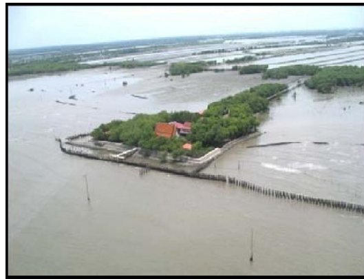
ภาพที่ 2-15 แนวปักเสาเข็มคอนกรีตหล่อแบบสี่เหลี่ยมของวัดขุนสมุทรราชต่อด้วยคอนกรีตหล่อแบบสามเหลี่ยม 49A2 ของจุฬาลงกรณ์มหาวิทยาลัย บริเวณวัดขุนสมุทรราช ตำบลแหลมฟ้า อำเภอพระสมุทรเจดีย์ จังหวัดสมุทรปราการ
