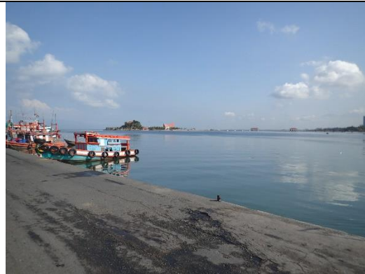
รูปที่ ๒.๑๘ ทำเทียบเรือประมงบางเสร่
