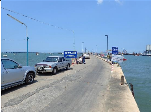
รูปที่ ๒.๑๙ ทำเทียบเรือประมงบางเสร่
