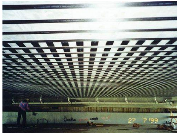
รูปที่ 2.19 การเสริมกำลังพื้นเพื่อรับ Positive Moment
