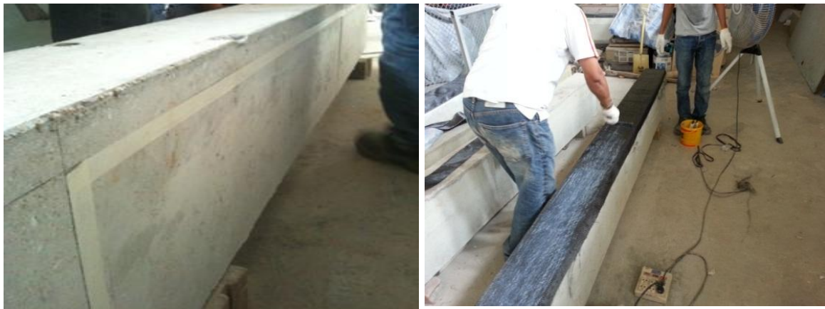
รูปที่ 3.4 การติดตั้งแผ่นไฟเบอร์ใยแก้ว
