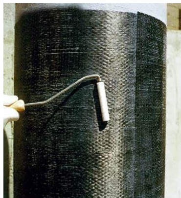
รูปที่ 2.21 การเสริมกำลังเสาโดยการพัน (Wrap)
