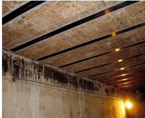
รูปที่ 2.18 การเสริมกำลังพื้นเพื่อรับ Positive Moment
