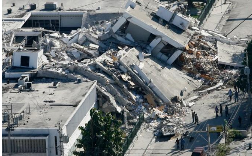
รูปที่ 2.2 การวิบัติแบบพื้นฐานของโครงสร้างเนื่องจากการวิบัติของเสา และจุดต่อคานเสา Haiti Earthquake [internet]
