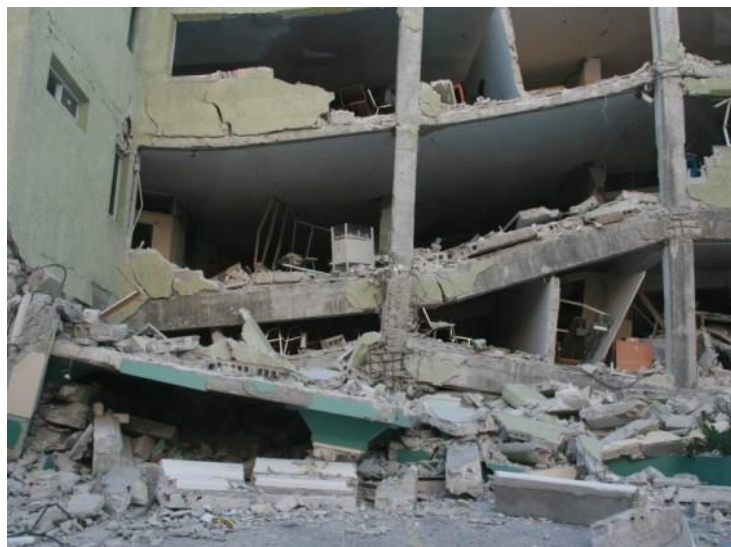
รูปที่ 2.3 การวิบัติของจุดต่อและคานโดยการเฉือนภายใต้ Haiti Earthquake [internet]
