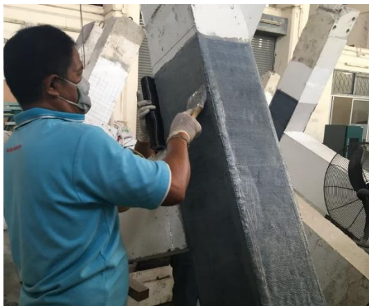
รูปที่ 3.15 การพันแผ่นไฟเบอร์
