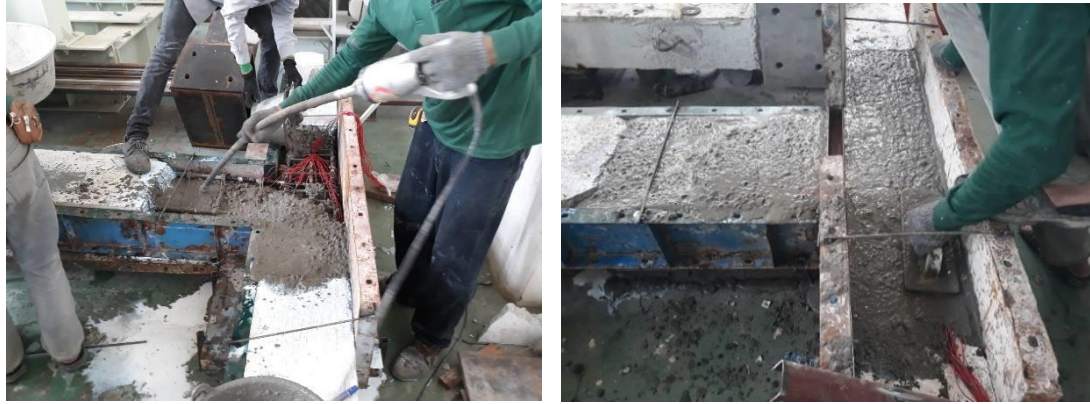
รูปที่ 3.12 เทคอนกรีต
