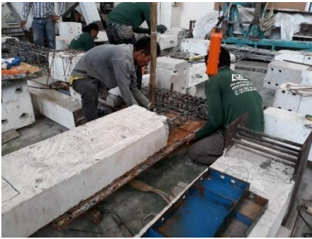
รูปที่ 3.11 เข้าแบบหล่อคอนกรีต
