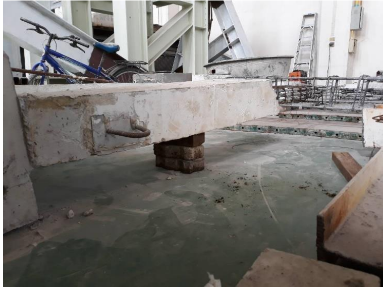
รูปที่ 3.8 หนุนด้านใต้เสาและคานเพื่อป้องกันการแอ่นตัว
