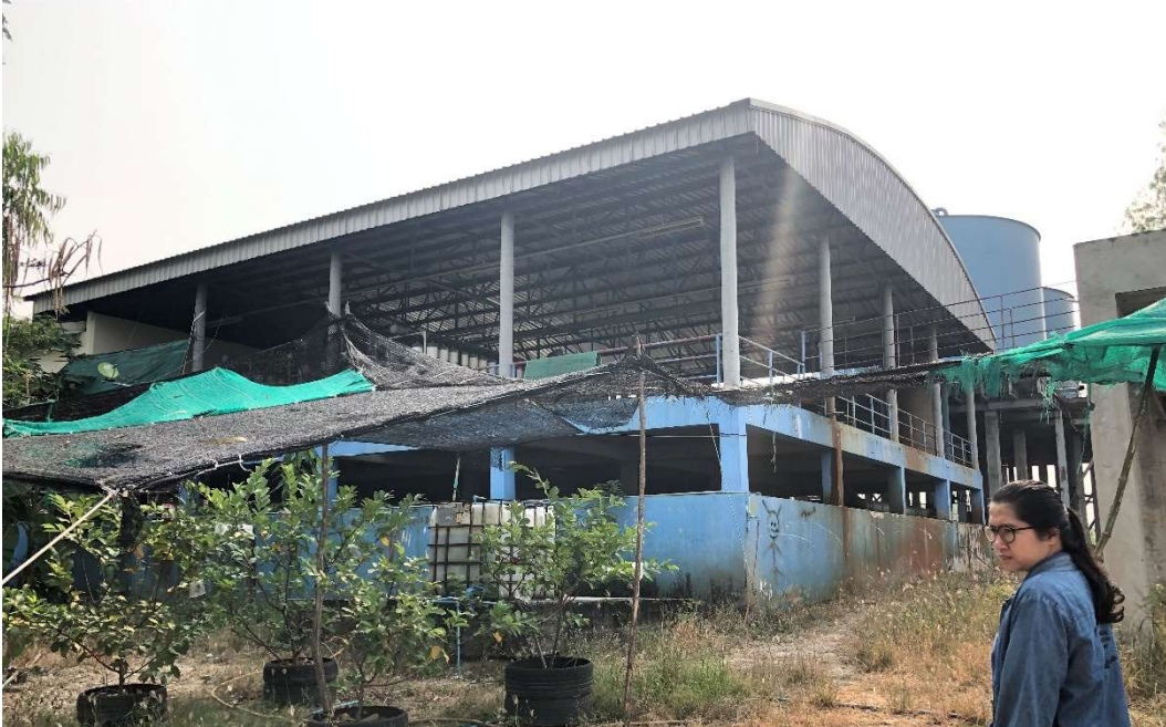
ภาพที่ 4- 78 (บน) ภาพจากอากาศยานไร้คนขับ (UAV) แสดงลักษณะทางกายภาพของบ่อ NP 5 (ล่าง) พบโรงสูบน้ำขนาดใหญ่ตั้งอยู่ แต่ปัจจุบันได้ปิดทำการแล้ว
