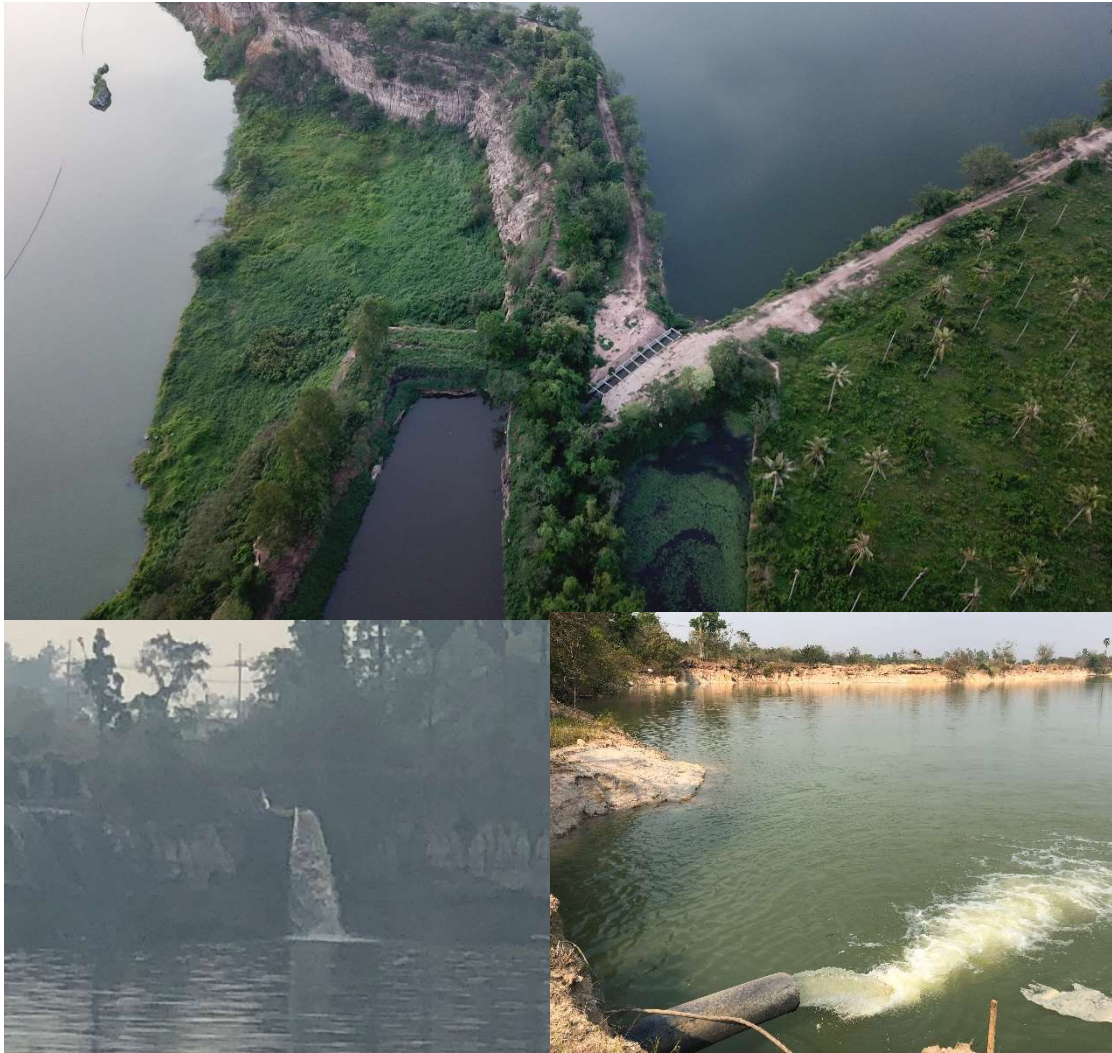
ภาพที่ 4- 81 (บน) ภาพจากอากาศยานไร้คนขับ (UAV) แสดงการต่อท่อผันน้ำระหว่างกลุ่มบ่อ NTL 6 – NTL 8 (ล่าง) ท่อผันน้ำภายในบ่อ NTL 4 –5 แสดงถึงการถ่ายเทน้ำไปมาของบ่อในความดูแลของบริษัทชลกิจไพศาล จำกัด
