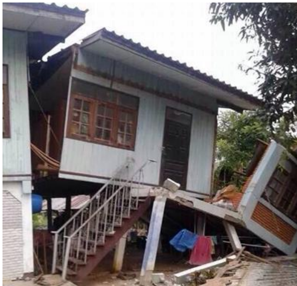
รูปที่ 1.1 ความเสียหายของอาคารคอนกรีตเสริมเหล็กจากแผ่นดินไหวแม่ลาว จังหวัดเชียงราย
