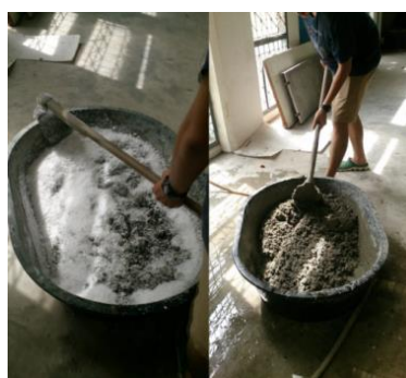
ภาพที่ 3-26 การผสมคอนกรีตกับเม็ดโพลีเมอร์เพื่อใหชุดแปลงทดลองคอนกรีตมีน้ำหนักเบา
