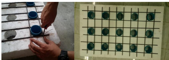
ภาพที่ 3-24 การผูกเหล็กตะแกรงสำหรับเพิ่มความแข็งแรงแปลงทดลองคอนกรีตและช่วยยึดแนวท่อพีวีซี
