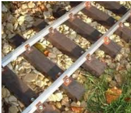
รูปที่ 2-4 ลักษณะของหมอนไม้
