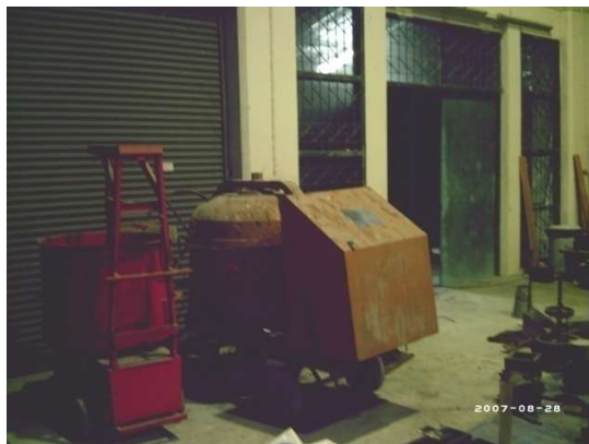
ภาพที่ 3.6 เครื่องผสมคอนกรีต
