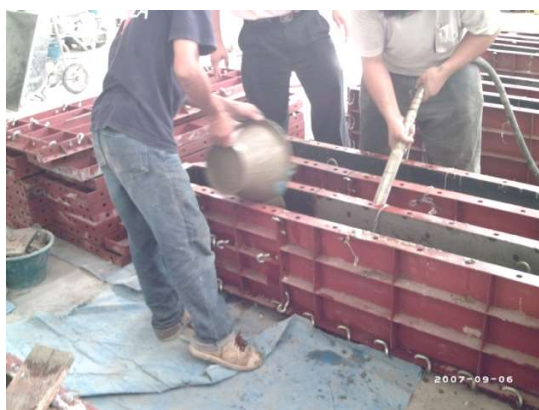
ภาพที่ 3.37 การจี้แบบหล่อคานตัวอย่างทดลองด้วยเครื่องจี้เขย่าคอนกรีต
