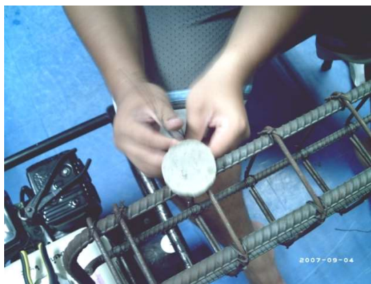
ภาพที่ 3.28 การติดลูกปูนเพื่อให้ได้ระยะหุ้มเหล็กเสริมที่ต้องการ
