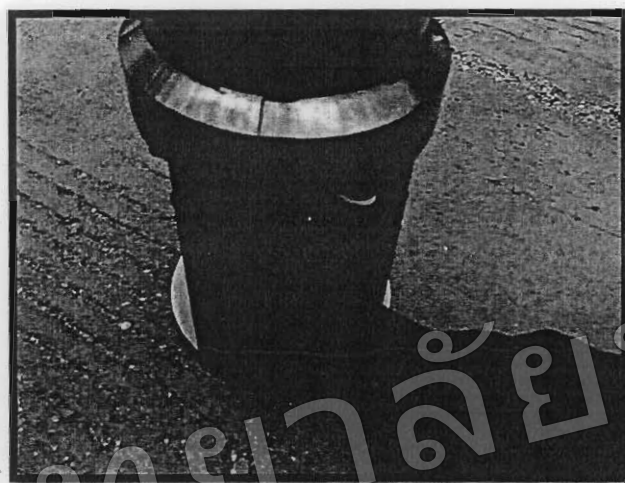
รูปที่ 3.11 เลื่อน O Ring ลง
