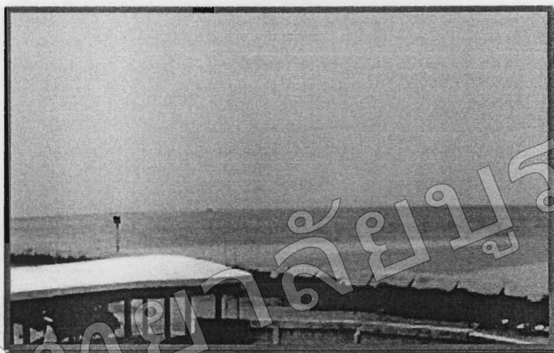
ภาพที่ 2.4 แสดงไม้กรอกทรายป้องกันการกัดเซาะชายฝั่ง
