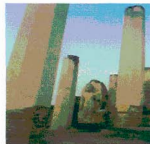
รูปที่ 1.2 ศิลาแลงใช้เป็นโครงสร้างของ พระพุทธรูป และเสาโบสถ์ก่อนโบกปูนทับ วัด มหาธาตุ อำเภอศรีสำราญ จังหวัดสุโขทัย
