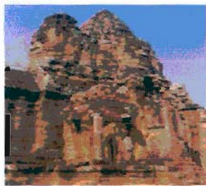
รูปที่ 1.1 ปราสาทบายน ประเทศกัมพูชา ใช้ศิลาแลง เป็นส่วนประกอบ ในการก่อสร้างโครงสร้างด้านใน ก่อนที่จะใช้หินทรายประดับด้านนอก
