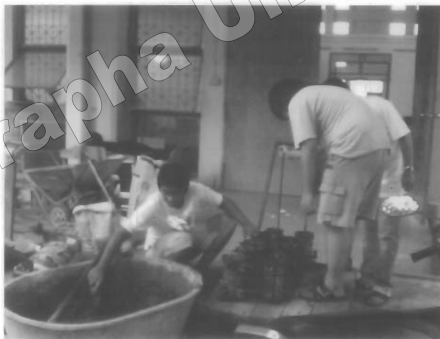
รูปที่ 4.5 เทคอนกรีตลงในแบบหล่อที่จัดเตรียมไว้ทั้งหมด
