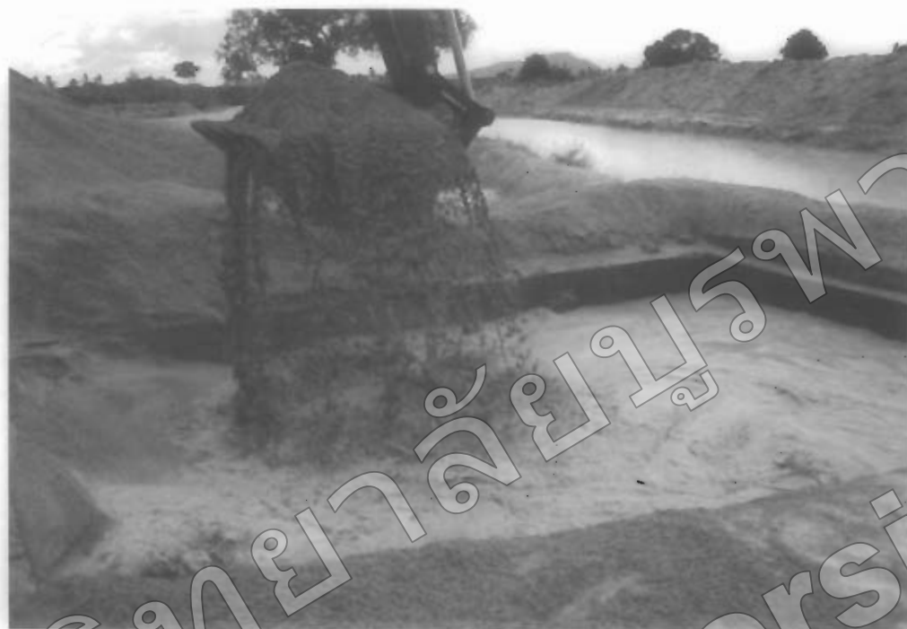
รูปที่ 2.9 บ่อล้างทรายครั้งที่ 2 ขจัดสิ่งที่ไม่ดีปนที่มากับทราย
