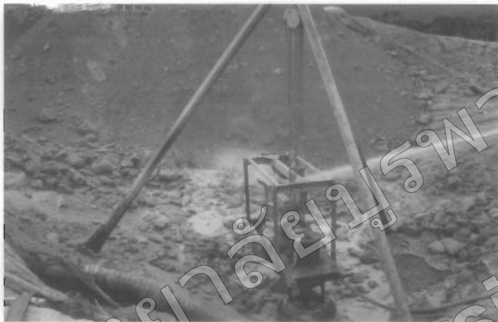
รูปที่ 2.7 แยกกรวดหรือก้อนหินที่มีขนาดใหญ่ออก
