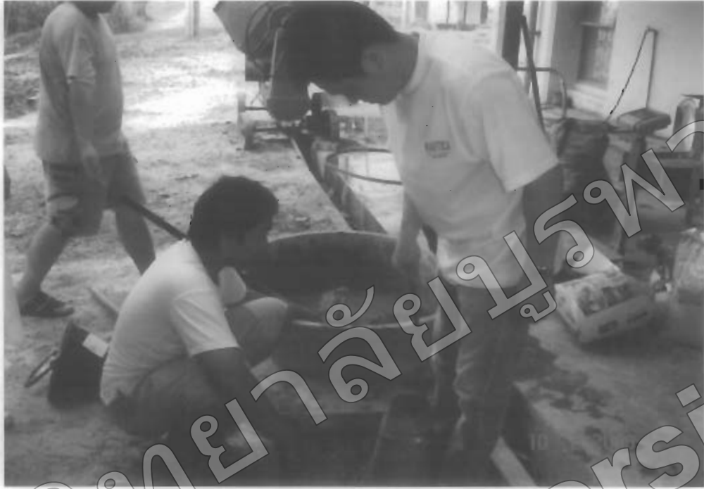
รูปที่ 4.2 ตรวจสอบค่าการขุ่นตัวของคอนกรีต
