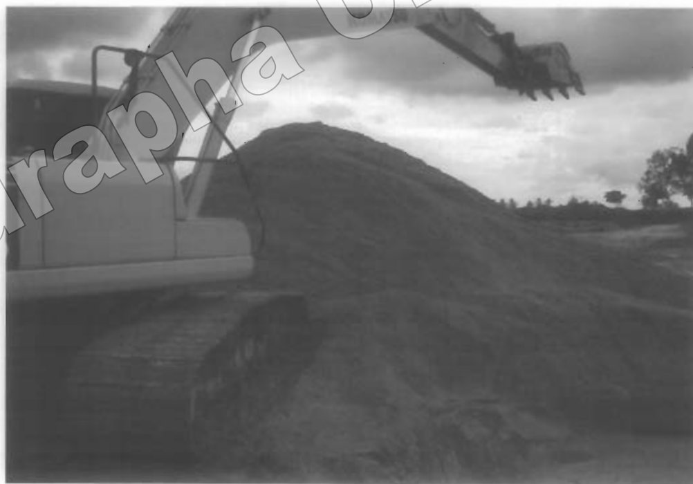
รูปที่ 2.10 ใช้รถแบ็คโฮ ทำการตักไปยังที่พักทราย
