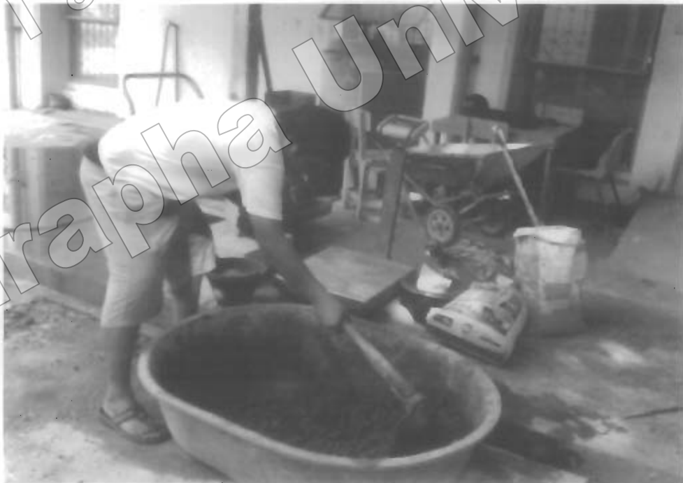
รูปที่ 4.1 ผสมคอนกรีตตามสัดส่วนที่ออกแบบไว้
