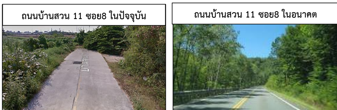
รูปที่ 3.2-8 การปรับปรุงเส้นทางการเข้าถึงรูปแบบใหม่ในอนาคต ที่มา : ( www.google.co.th/maps )
