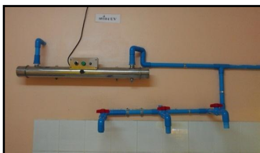
เครื่อง Ultraviolet (UV) ฆ่าเชื้อโรคก่อน บรรจุน้ำใส่ภาชนะ
