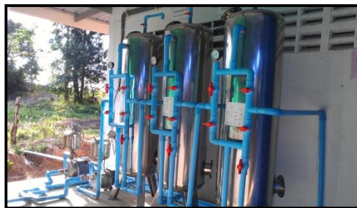
ถังกรองน้ำ 3 ประเภท คือ กรองคาร์บอน กรองแมงกานีส และกรองเรซิน
