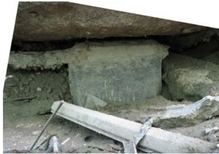
รูปที่ 1-4 ปัญหาที่เกิดขึ้นที่จุดสัมผัสระหว่างหัวเสาเข็มและพื้นชั้นล่าง
