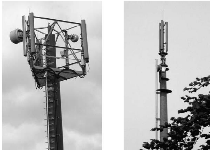
รูปที่ 3.2-6 สายอากาศสถานีฐานที่มีการแบ่งการรับส่งจำนวน 3 ส่วนๆละ 120 °
