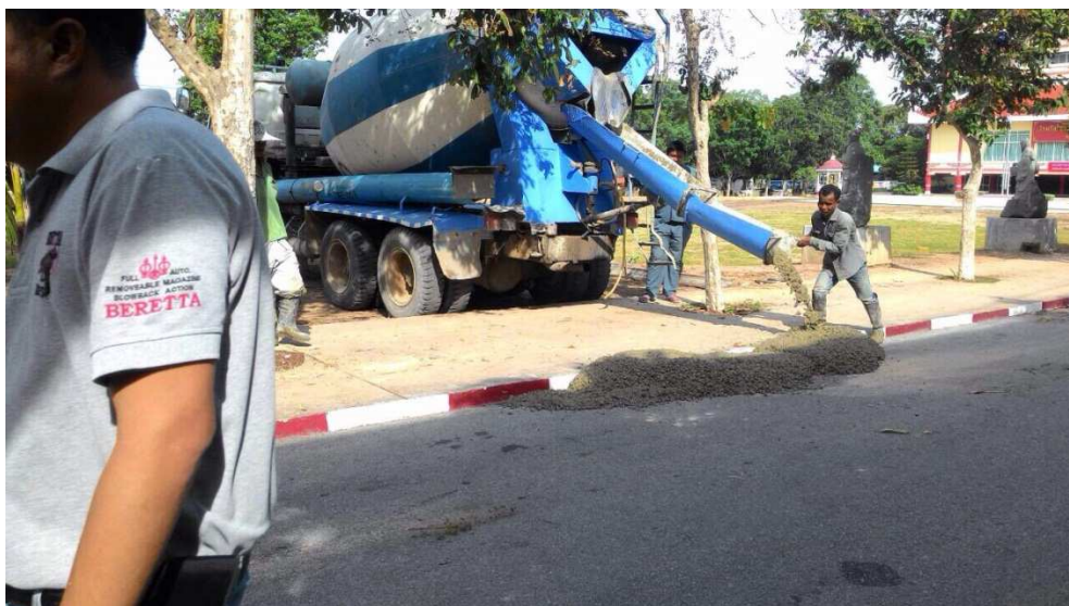
ภาพที่ 4-7 การปรับปรุงพื้นที่และเทพื้นเพื่อทำเป็นพื้นที่จอดรถ
