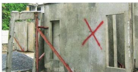
ภาพที่ 2-96 แผ่นผนังที่มีรอยร้าว (เทคธรรม ยอดพฤติกาณ์, 2555)
