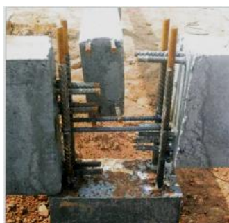
ภาพที่ 2-53 การวางคานบนเหล็กคาครัด (เทอดธรรม ยอดพฤติกัรณั, 2555)
