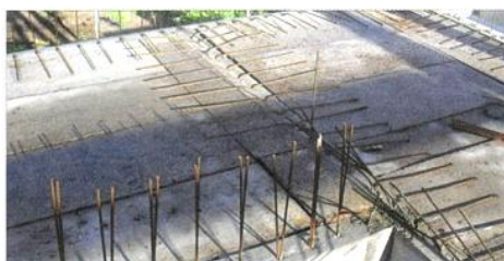
ภาพที่ 2-71 หัวคานที่มีการพับเหล็กกันร้าว (เทอดธรรม ยอดพฤติกการณ์, 2555)
