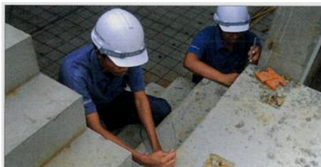
ภาพที่ 2-88 การตรวจสอบระดับของบันไดด้วยระดับน้ำ (เทอดธรรม ยอดพฤติการณ์, 2555)
