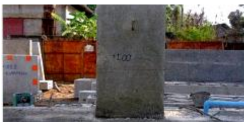
ภาพที่ 2-39 การตีเส้นระดับบนเสาเพื่อตรวจสอบระดับเสา (เทศบาลนครขอนแก่น, 2555)
