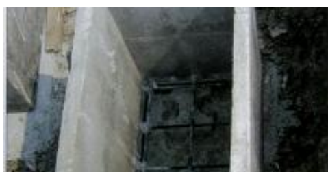
ภาพที่ 2-20 ตะแกรงเหล็กฐานรากที่ไม่มีสนิมเกาะ (เทอดธรรม ยอดพฤติการณ์, 2555)
