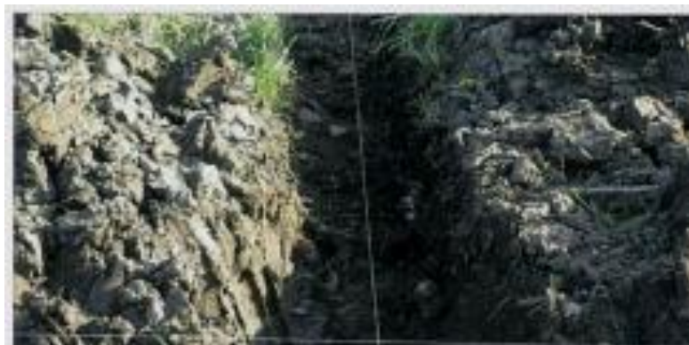
ภาพที่ 2-30 การวางแนวเสาตอม่อ (เทอดธรรม ยอดพฤติกัรณั, 2555)
