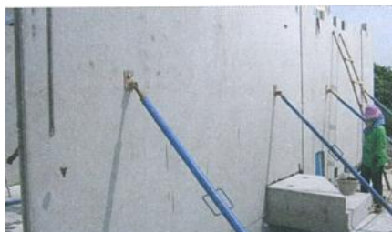
ภาพที่ 2-103 การใช้เหล็กค้ำยันเพื่อปรับระยะผนัง (เทอดธรรม ยอดพฤติกการณ์, 2555)
