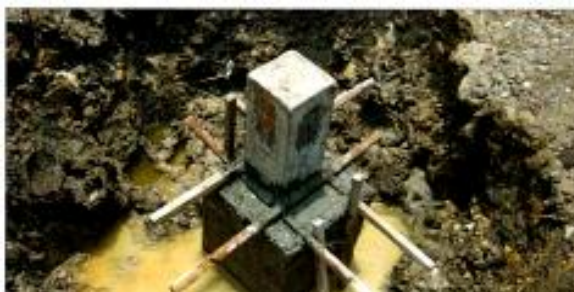
ภาพที่ 2-32 การวัดเสาคอม่อด้วยไม้ (เทอดธรรม ยอดพฤติกัรณ, 2555)
