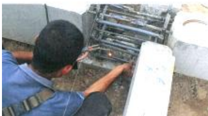
ภาพที่ 2-51 การเชื่อมเหล็กคาคเพื่อวางคาน (เทอดธรรม ยอดพฤติกัรณั, 2555)
