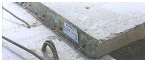
ภาพที่ 2-63 การวางตำแหน่งแผ่นพื้น (เทอดธรรม ขอดพฤติการณ, 2555)
