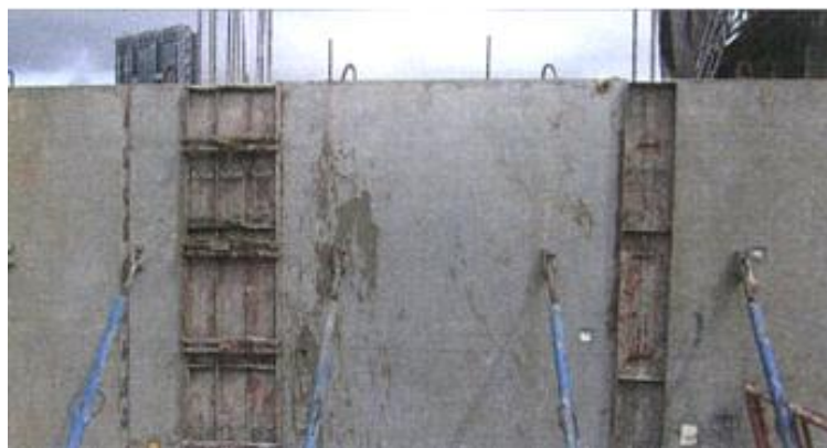
ภาพที่ 2-109 การเข้าแบบเทคอนกรีตรอยต่อผนัง (เทอดธรรม ยอดพฤติกการณ์, 2555)
