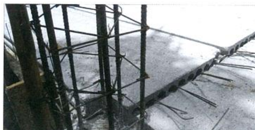
ภาพที่ 2-65 การวางแผ่นพื้น Hollow core บริเวณมุมเสา (เทอดธรรม ขอดพฤติการณ, 2555)
