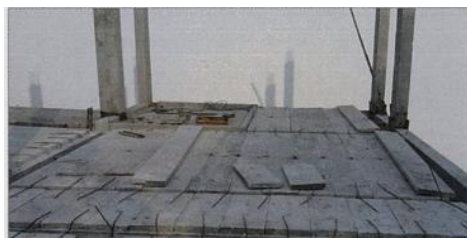
ภาพที่ 2-70 แผ่นพื้นที่มีการเชื่อมเหล็ก Shear key (เทอดธรรม ยอดพฤติกการณ์, 2555)
