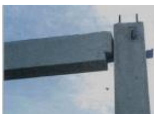
ภาพที่ 2-52 การใส่ Socket 3 เข้าไปในเสา (เทอดธรรม ยอดพฤติกัรณั, 2555)
