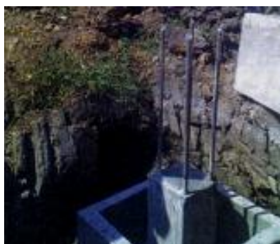
ภาพที่ 2-29 การยิงเอ็นตรวจสอบระดับของเสาตอม่อ (เทอดธรรม ยอดพฤติกการณ์, 2555)
