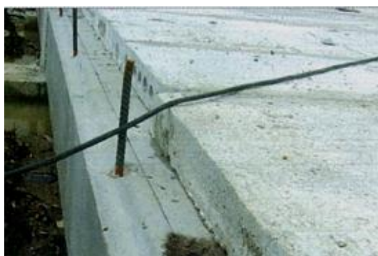
ภาพที่ 2-67 ระยาระยั้งของพื้น Hollow Core โดยทั่วไป (เทอดธรรม ยอดพฤติกการณ, 2555)
