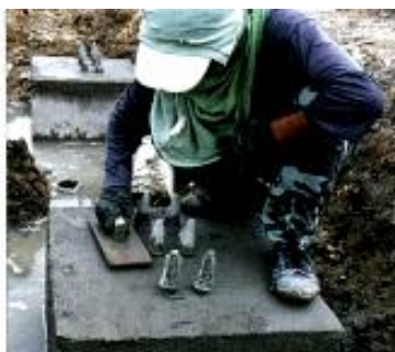
ภาพที่ 2-34 การขัดหยาบผิวบนของฐานราก (เทอดธรรม ยอดพฤติกัรณ, 2555)
