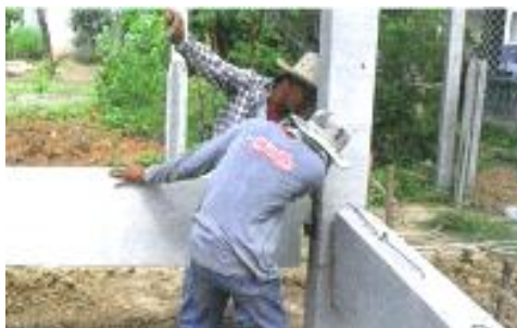
ภาพที่ 2-54 การวางคานบน Socket 3 (เทอดธรรม ยอดพฤติกัรณั, 2555)
