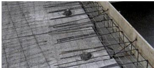
ภาพที่ 2-72 การวางเหล็กเสริม (เทอดธรรม ยอดพฤติการณ์, 2555)
