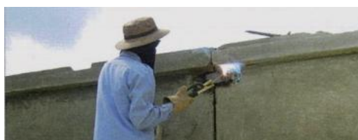
ภาพที่ 2-108 การเชื่อมยึด Plate เหล็กของผนังที่มีรอยต่อเป็นแบบเชื่อมยึด (เทอดธรรม ยอดพฤติการณ์, 2555)
