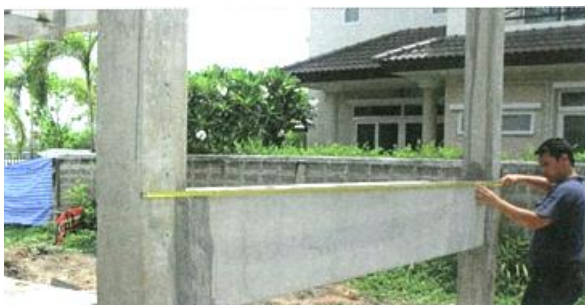
ภาพที่ 2-85 การวัดระยะในแนวราบของคานรองรับ (เทอดธรรม ยอดพฤติกการณ์, 2555)
