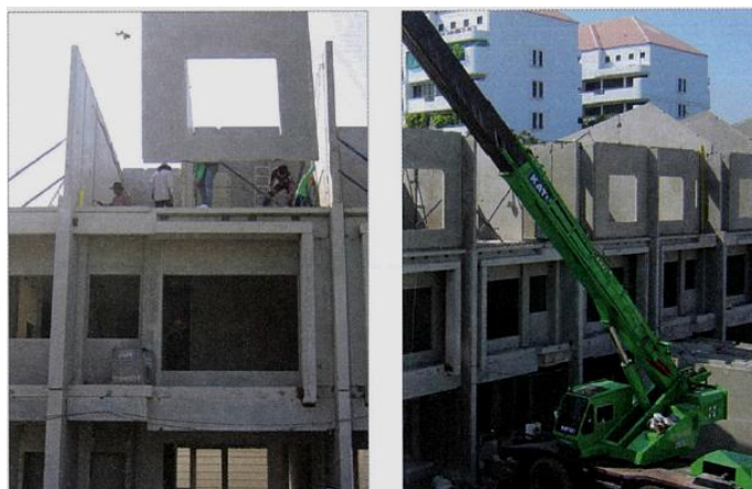
ภาพที่ 2-17 ยกแผ่นผนังคอนกรีตสำเร็จรูปด้วยรถเครน (เทอดธรรม ยอดพฤติกาณ์, 2555)
