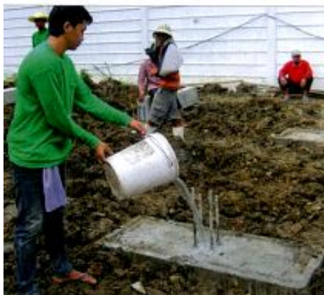
ภาพที่ 2-19 การทำความสะอาดฐานราก (เทอดธรรม ยอดพฤติการณ์, 2555)
