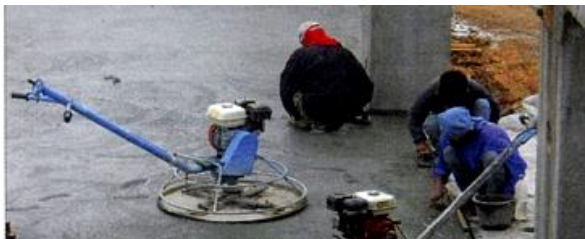
ภาพที่ 2-75 การขัดมันผิวคอนกรีต (เทอดธรรม ยอดพฤติกการณ์, 2555)
