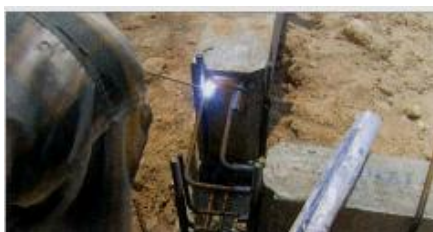
ภาพที่ 2-49 การเชื่อมยึดเหล็กแกนคานขึ้นอยู่กับความต้องการของผู้ควบคุมงาน (เทอดธรรม ยอดพฤติกัณณ์, 2555)
