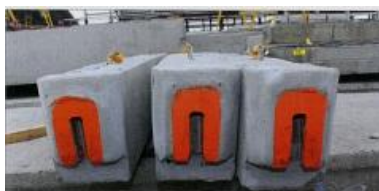
ภาพที่ 2-46 ตำแหน่ง Socket ของคาน (เทอดธรรม ยอดพฤติกัณณ์, 2555)
