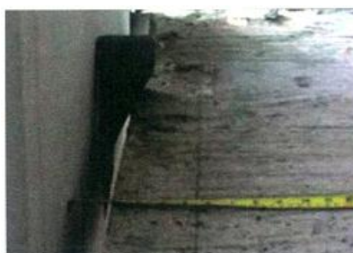
ภาพที่ 2-104 การใช้ลิ้มตอกปรับระยะผนัง (เทอดธรรม ยอดพฤติกการณ์, 2555)
