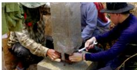
ภาพที่ 2-38 การขันน็อตตัวเมียเพื่อปรับระดับเสา (เทศบาลนครขอนแก่น, 2555)
