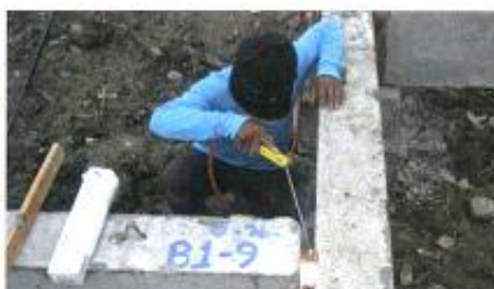
ภาพที่ 2-50 การเชื่อมยึด Socket (เทอดธรรม ยอดพฤติกัณณ์, 2555)
