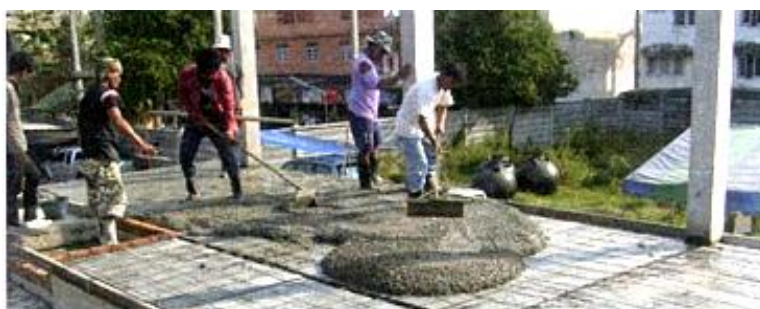
ภาพที่ 2-73 การเทคอนกรีตทับหน้า (เทอดธรรม ยอดพฤติการณ์, 2555)
