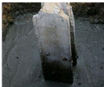
ภาพที่ 2-23 การรองพื้นด้วยคอนกรีตหยาบ (เทอดธรรม ยอดพฤติการณ์, 2555)
