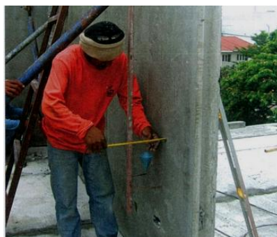
ภาพที่ 2-105 การตรวจสอบแนวตั้งของผนัง (เทอดธรรม ยอดพฤติกการณ์, 2555)
