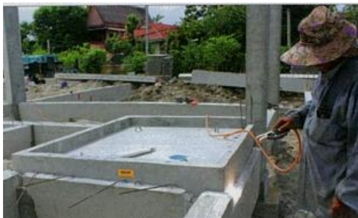
ภาพที่ 2-81 การเชื่อมยึดพื้นลาดสำเร็จรูป (เทอดธรรม ขอดพฤติการณ, 2555)
