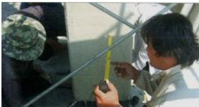
ภาพที่ 2-41 การวัดระยะจากผิวของเสาถึงแนวเส้นตั้ง (เทอดธรรม ยอดพฤติกการณ์, 2555)
