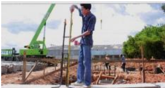
ภาพที่ 2-27 การวัดขนาด Dowel ของเสาตอม่อ (เทอดธรรม ยอดพฤติกการณ์, 2555)
