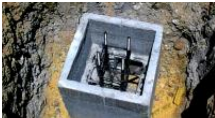
ภาพที่ 2-36 เหล็ก Dowel ของเสา (เทอดธรรม ยอดพฤติการณ์, 2555)
