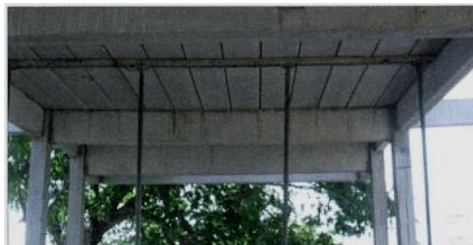
ภาพที่ 2-69 การค้ำยันใต้ท้องพื้น (เทอดธรรม ยอดพฤติกการณ์, 2555)
