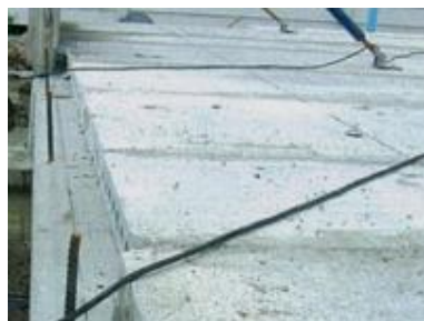
ภาพที่ 2-102 การตีเส้นแนวผนังบนคาน (เทอดธรรม ยอดพฤติการณ์, 2555)
