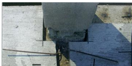
ภาพที่ 2-64 การวางแผ่นพื้นเข้ามุมเสา (เทอดธรรม ขอดพฤติการณ, 2555)
