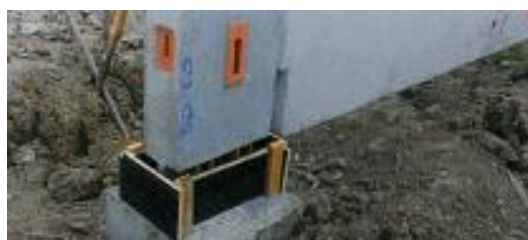
ภาพที่ 2-43 การเข้าแบบรอยต่อเสา (เทอดธรรม ขอดพฤติการณ, 2555)
