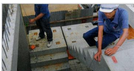
ภาพที่ 2-89 การตรวจสอบระดับของบันไดด้วยระดับน้ำ (เทอดธรรม ยอดพฤติการณ์, 2555)
