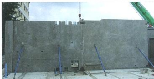
ภาพที่ 2-106 การปรับแนวตั้งของผนังด้วยท่อเหล็กค้ำยัน (เทอดธรรม ยอดพฤติการณ์, 2555)
