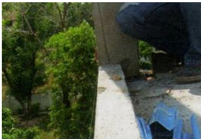
ภาพที่ 2-80 การจิ้งเอนตรวจสอบแนวของขอบพื้นลาดสำเร็จรูป (เทอดธรรม ขอดพฤติการณ, 2555)
