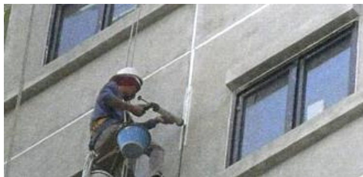
ภาพที่ 2-110 การอูครอยต่อผนังด้วยวัสดุกันน้ำ (เทอดธรรม ยอดพฤติกการณ์, 2555)
