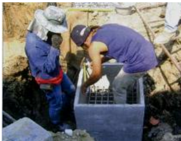
ภาพที่ 2-18 การวัดขนาดฐานราก (เทอดธรรม ยอดพฤติกาณ์, 2555)
