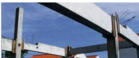
ภาพที่ 2-56 การเข้าแบบคานแนบสนิทเพื่อเทคอนกรีต (เทอดธรรม ยอดพฤติกัรณั, 2555)
