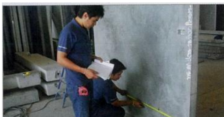
ภาพที่ 2-94 การวัดขนาดและตำแหน่ง Plate ในชั้นงาน (เทคธรรม ยอดพฤติกาณ์, 2555)
