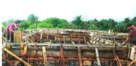
ภาพที่ 2-59 การวัดระยะคานเพื่อวางแผ่น (เทอดธรรม ยอดพฤติกัณณ์, 2555)
