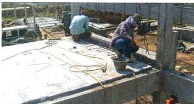
ภาพที่ 2-66 ระยาระยั้งของพื้น Plank โดยทั่วไป (เทอดธรรม ยอดพฤติกการณ, 2555)
