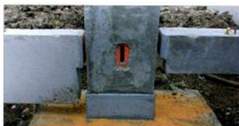
ภาพที่ 2-44 เสาที่เทคอนกรีตรอยต่อเสาเรียบร้อยแล้ว (เทอดธรรม ขอดพฤติการณ, 2555)
