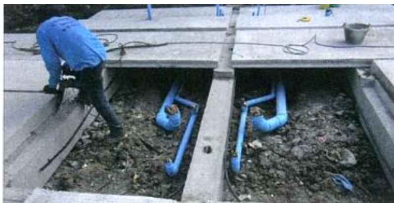
ภาพที่ 2-78 หลังคานที่มีเศษปูนทำให้ต้องสกัดออกก่อนวางพื้นถาด (เทอดธรรม ยอดพฤติการณ์, 2555)
