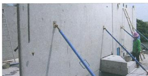
ภาพที่ 2-107 การปรับแนวตั้งของผนังด้วยท่อเหล็กค้ำยัน (เทอดธรรม ยอดพฤติการณ์, 2555)
