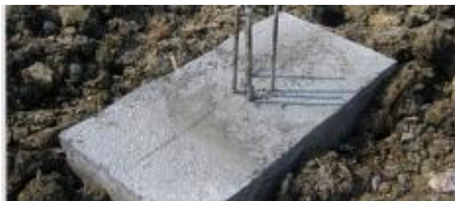
ภาพที่ 2-40 การตีเส้นบนฐานรากเพื่อวัด Center เสา (เทอดธรรม ยอดพฤติกการณ์, 2555)
