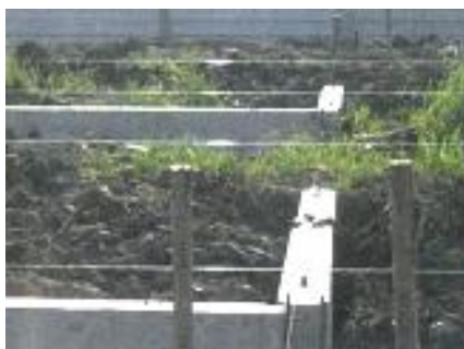
ภาพที่ 2-55 การขึงเอ็นตรวจสอบแนวคาน (เทอดธรรม ยอดพฤติกัรณั, 2555)
