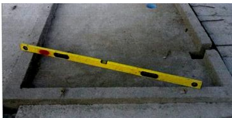
ภาพที่ 2-79 การใช้ระดับน้ำตรวจสอบระดับของพื้นถาด (เทอดธรรม ยอดพฤติการณ์, 2555)
