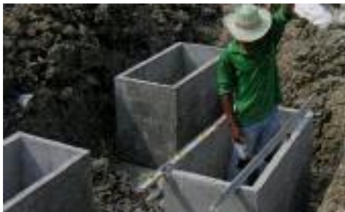
ภาพที่ 2-25 การจิ้งเอ็นแนวฐานราก (เทอดธรรม ยอดพฤติกวณ, 2555)
