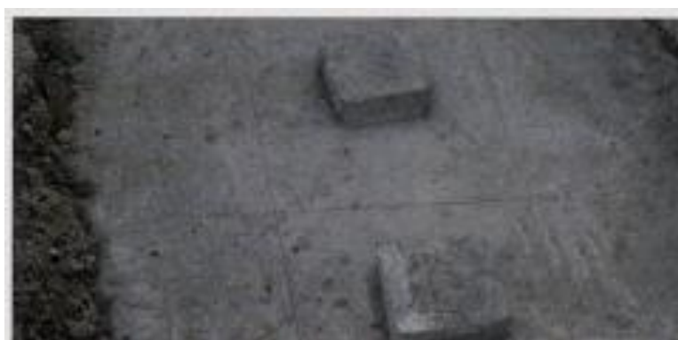
ภาพที่ 2-26 การตีเส้นอ้างอิงบนพื้นคอนกรีต (เทอดธรรม ยอดพฤติกวณ, 2555)
