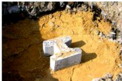
ภาพที่ 2-22 การรองพื้นด้วยทรายหยาบ (เทอดธรรม ยอดพฤติการณ์, 2555)
