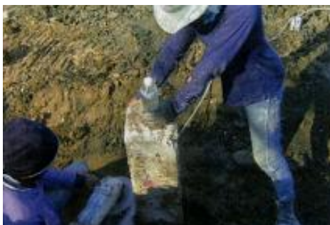
ภาพที่ 2-21 การตัดหัวเข็ม (เทอดธรรม ยอดพฤติการณ์, 2555)
