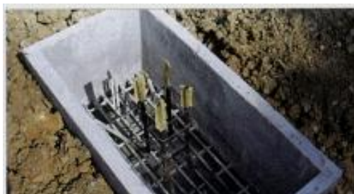
ภาพที่ 2-28 รายละเอียด Dowel ของเสาตอม่อ (เทอดธรรม ยอดพฤติกการณ์, 2555)
