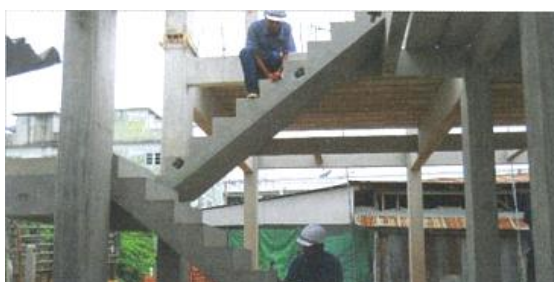
ภาพที่ 2-90 การตั้งค้ำเพื่อตรวจสอบแนวของบันได (เทอดธรรม ยอดพฤติการณ์, 2555)
