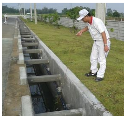
ภาพที่ 3-9 รางระบายน้ำสู่ภายนอกโรงงาน
