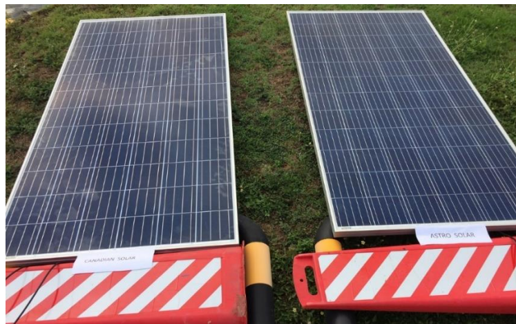
ภาพที่ 4-1 การติดตั้งเพื่อเปรียบเทียบประสิทธิภาพของแผงทั้งสองยี่ห้อ
