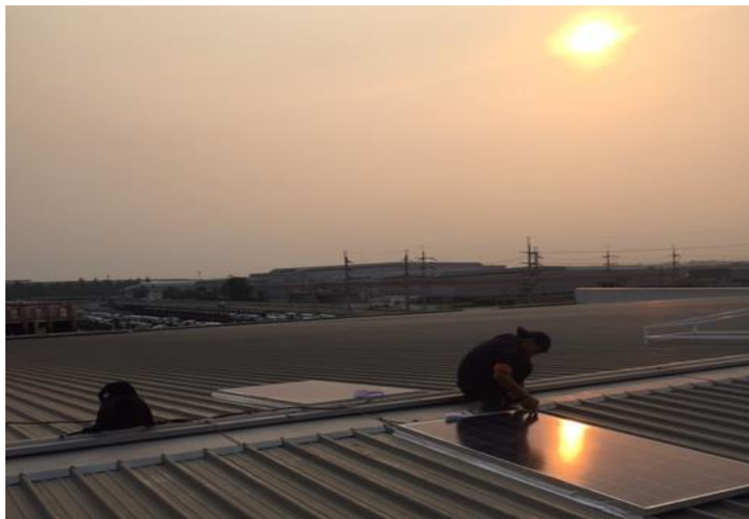
ภาพที่ 4-3 การติดตั้งเพื่อเปรียบเทียบหาทิศที่มีประสิทธิภาพการรับแสงสูงสุด
